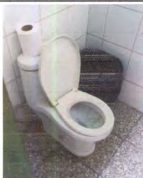
Foto 9: Reparacion de drenaje y de sanitario tapado
