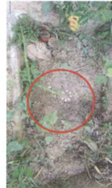
Foto 4: cambio de llave de paso
