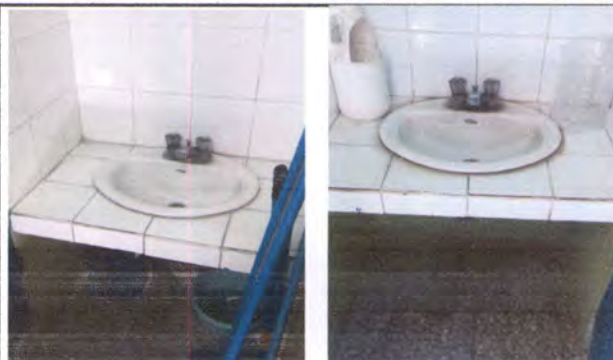
Foto 8: Cambio de valvulas en lavamanos
