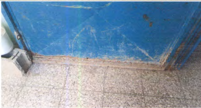
Foto 3: cambio de lamina y tubo de puertas
