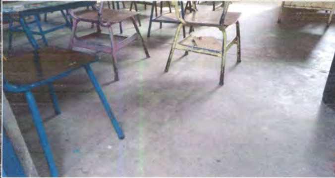
Foto1: cambio de piso
