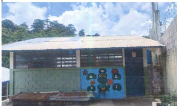
Foto 7: cambio de techo
