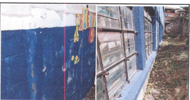
Foto 6: MURO EXTERIOR: Zanjeado en muro exterior, Aplicación de mortero para impermeabilización y aplicación de pintura a ambos lados del muro.
