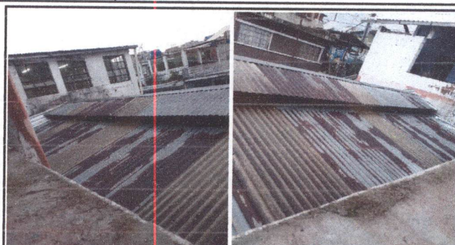
Foto 2: TECHO DE PATIO: Desmontaje y enlaminado a dos aguas con claraboya central, en patio del primer nivel.
