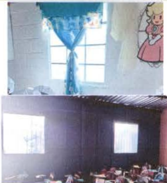
Sustitución de lámina por lámina troquelada aluzinc calibre 26 , en aula de 4to. Grado.
