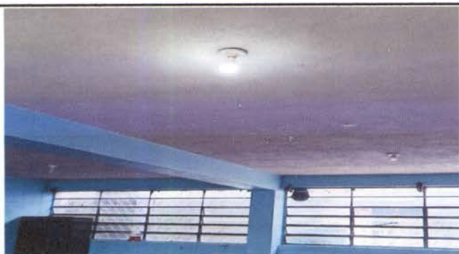
Sustitución de focos por lámpara led
