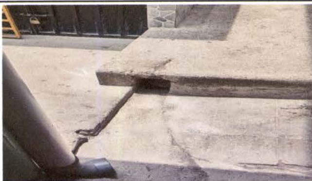
Reparación de tubería, línea principal de agua pluvial
