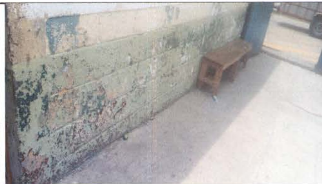
pintura en muros interiores y exteriores
