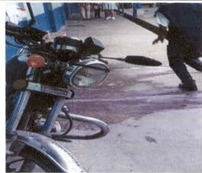
Sustitución de piso torta en entrada principal.
