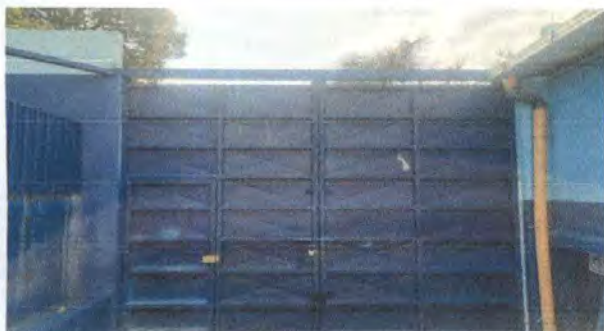
Foto1: Suministro y Mantenimiento a porton Principal de 4.40 mts por 3.70 mts limpieza, cepillado, soldadura, enmasillado y aplicación de pintura anticorrosiva color azul.
