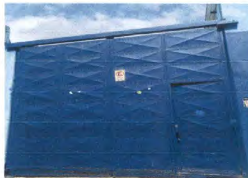
Foto1: Suministro y Mantenimiento a porton Principal de 4.40 mts por 3.70 mts limpieza, cepillado, soldadura, enmasillado y aplicación de pintura anticorrosiva color azul.
