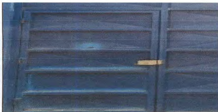
Foto 4: Sustitución de chapa Yale a porton principal.
