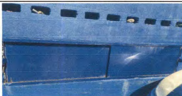
Foto 3: Ampliacion y repello de basurero exterior, Mantenimiento a puerta de basurero exterior lijado, aplicacion de pintura anticorrosiva color azul y lubricacion
