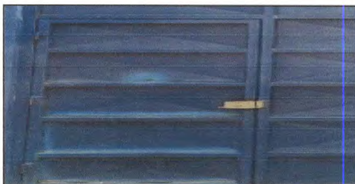
Foto 4: Sustitución de chapa Yale a porton principal.
