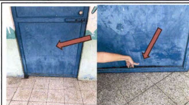
Foto 3 y 4: 4. PUERTAS DE METAL 4.1 Mantenimiento a estructura de 8 puertas de aulas ( lijado, sujeciones, aplicación de pintura )
