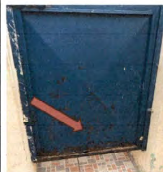
Foto 19 y 20: 10. SERVICIOS SANITARIOS Y SUS ACCESORIOS 10.1 Mantenimiento a estructura (lijado, sujeciones, aplicación de pintura) a 4 puertas de sanitarios niñas
