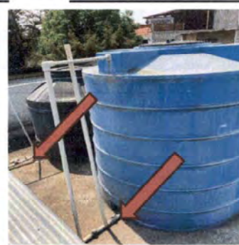
Foto 15 y 16: 18. REPARACIÓN Y MANTENIMIENTO DE DEPOSITOS DE AGUA 18.5 Sustitución de accesorios de 2 depositos de agua
