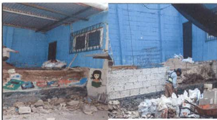
Foto 28: Reparación de pared del escenario
