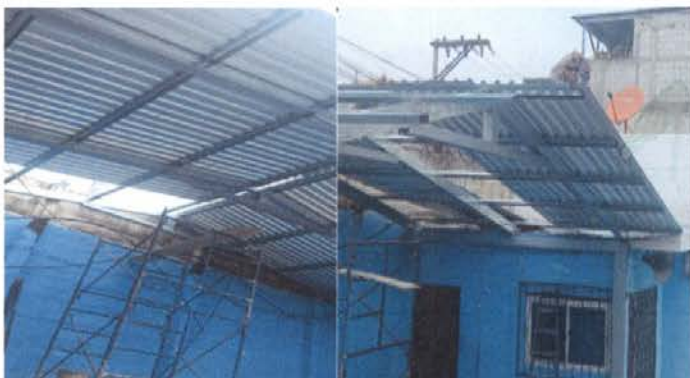
Foto 4: Estructura de techo del escenario se fabrica con costaneras de 6" sus bases y costaneras de 4" para los postes paralelos que sujetan la lámina, la estructura se trabajará a dos aguas.
