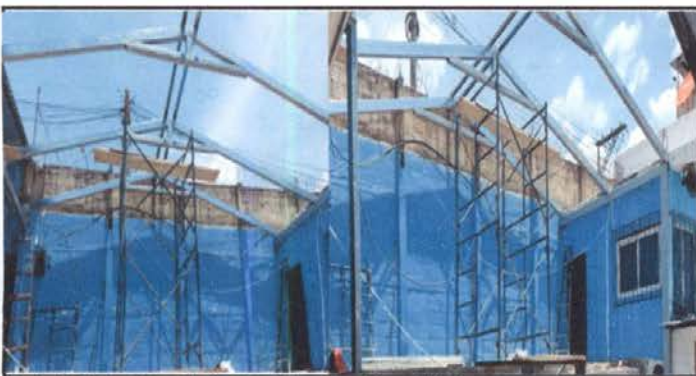
Foto 5: Estructura de techo del escenario se fabrica con costaneras de 6" sus bases y costaneras de 4" para los postes paralelos que sujetan la lámina, la estructura se trabajará a dos aguas.
