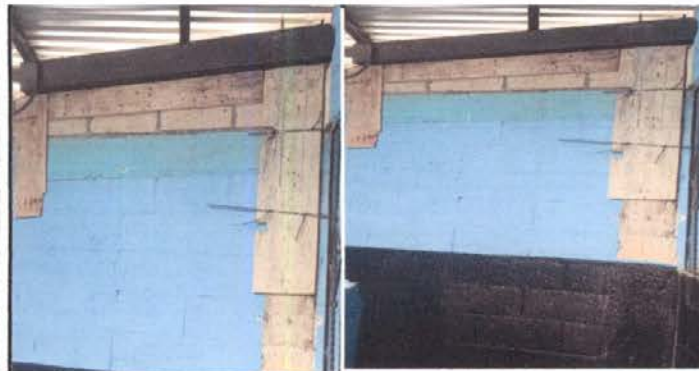
Foto 23: Levantado de pared del pasillo del fondo del segundo nivel.
