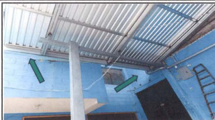
Foto 14: Bajadas de agua en el escenario y cambio de canales de PVC por canal aluzinc calibre 26
