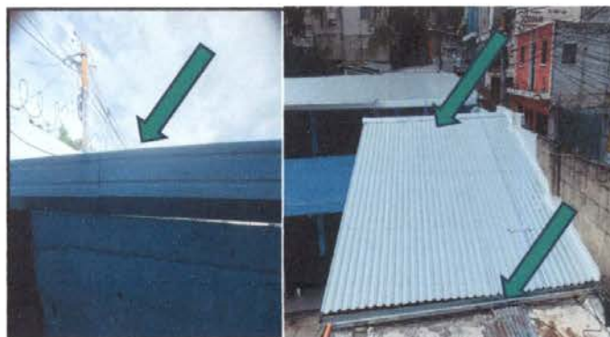
Foto 12: Sustitución de canal PVC por canal aluzinc calibre 26 en el escenario
