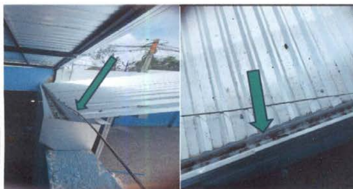
Foto 11: Sustitución de canal PVC por canal aluzinc calibre 26 en el escenario
