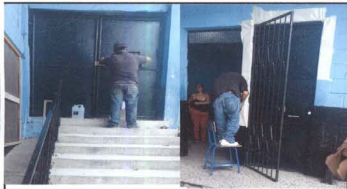
Foto 19: Pintura de puertas.
