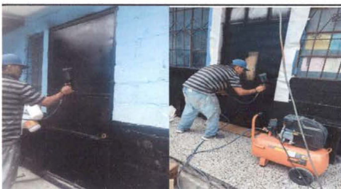
Foto 22: Pintura de puertas.
