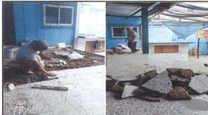
Foto 10: Sustitución de piso de granito en el escenario
