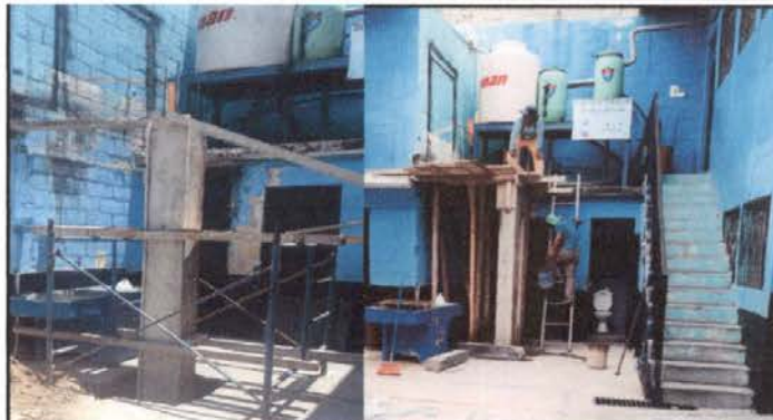
Foto 26: Fundición de losa para instalación de tinaco para agua.
