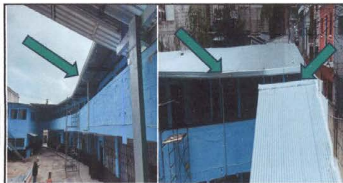
Foto 17: Cambio de canal PVC por canal Aluzinc calibre 26
