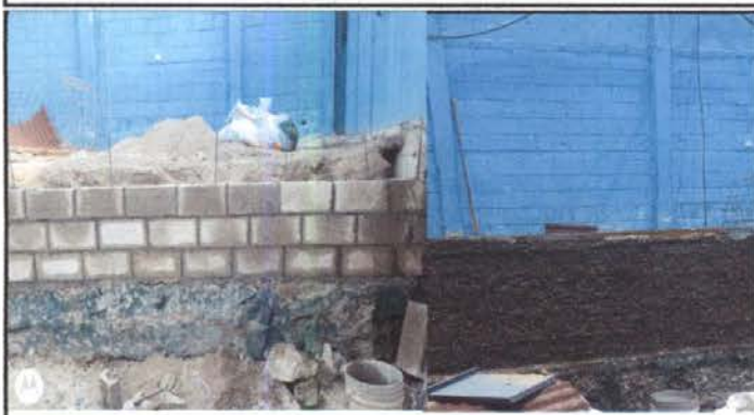
Foto 29: Reparación de pared del escenario
