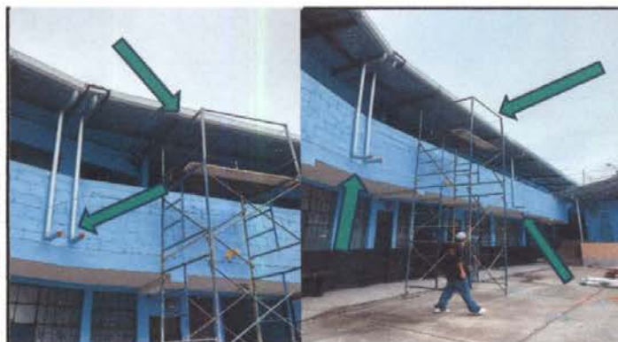
Foto 15: Cambio de bajadas de agua y cambio de canales PVC por canales de Aluzinc Calibre 26
