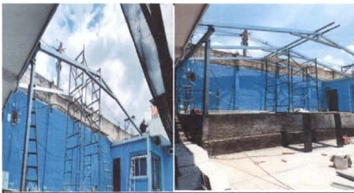
Foto 6: Estructura de techo del escenario se fabrica con costaneras de 6" sus bases y costaneras de 4" para los postes paralelos que sujetan la lámina, la estructura se trabajará a dos aguas.
