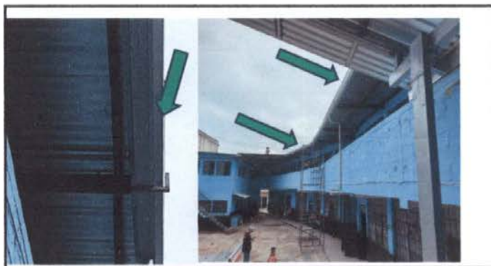
Foto 18: Cambio de canal PVC por canal Aluzinc calibre 26
