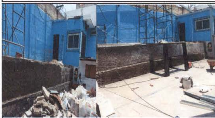
Foto 30: Reparación de pared del escenario
