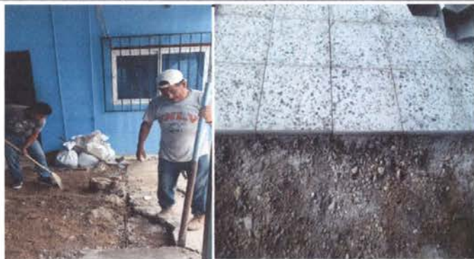
Foto 8: Sustitución de piso de granito en el escenario
