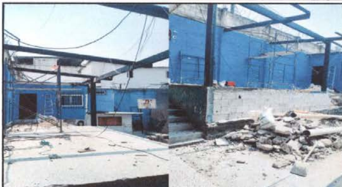
Foto 2: Sustrucción de lámina del escenario por lámina troquelada de aluzinc calibre 26 anclada con tornillo punta de broca sellada con sicaflex
