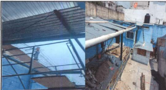
Foto 1: Sustrucción de lámina del escenario por lámina troquelada de aluzinc calibre 26 anclada con tornillo punta de broca sellada con sicaflex
