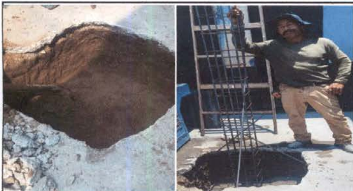
Foto 25: Fundición de losa para instalación de tinaco para agua.
