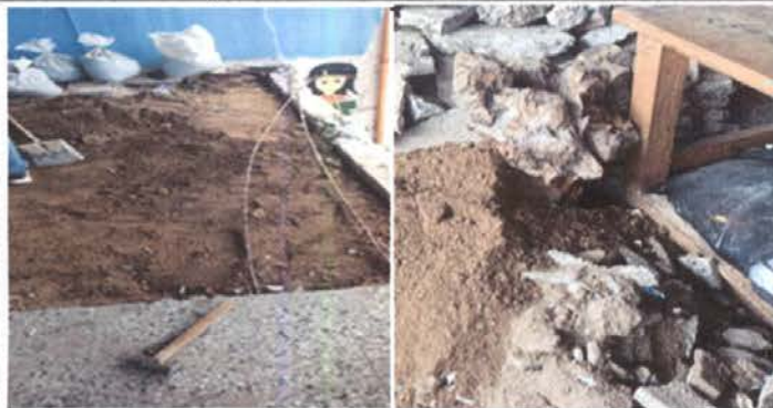
Foto 7: Sustitución de piso de granito en el escenario
