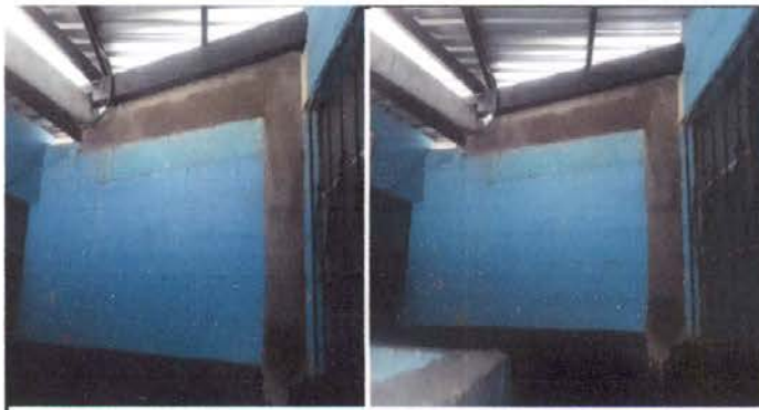
Foto 24: Levantado de pared del pasillo del fondo del segundo nivel.
