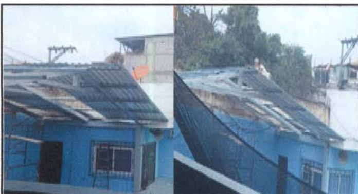
Foto 3: Estructura de techo del escenario se fabrica con costaneras de 6" sus bases y costaneras de 4" para los postes paralelos que sujetan la lámina, la estructura se trabajará a dos aguas.
