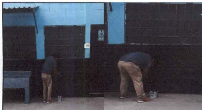
Foto 21: Pintura de zócalo.
