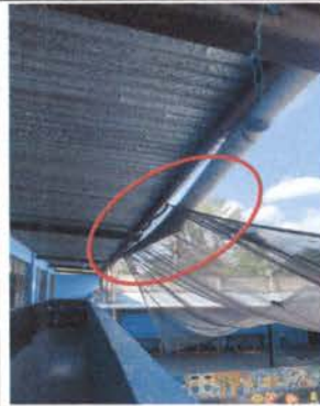
Foto 02: Sustrucción de canal PVC por aluzinc calibre 26. Dicho canal tendrá una carrera a todo lo largo del techo superior lo cual irá sostenida por una armadura de costanera de 3" X 2"
