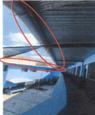
Foto 02: Sustrucción de canal PVC por aluzinc calibre 26. Dicho canal tendrá una carrera a todo lo largo del techo superior lo cual irá sostenida por una armadura de costanera de 3" X 2"
