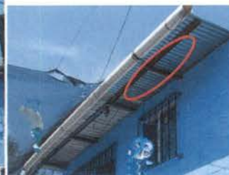
Foto 04: Sustrucción de lámina de aula 2do nivel por lámina troquelada de aluzinc calibre 26 con instalación incluida
