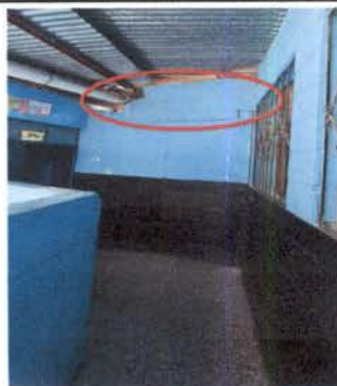
Foto 05: Levantado de pared del fondo del pasillo segundo nivel, dicha pared se levantará de block en forma triangular y su terminación será en área gris
