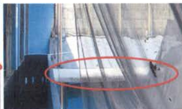
Foto 03: Sustrucción de canal de PVC en el escenario en su totalidad y cambio de forma a dos aguas se colocarán canales cuadrados de aluzinc calibre 26 con tope con su respectiva bajada
