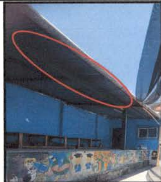
Foto 01: Sustrucción de lámina del escenario por lámina troquelada de Aluzinc calibre 26 con instalación y materiales incluidos.
