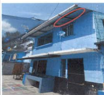
Foto 04: Sustrucción de lámina de aula 2do nivel por lámina troquelada de aluzinc calibre 26 con instalación incluida
