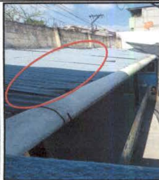
Foto 01: Sustrucción de lámina del escenario por lámina troquelada de Aluzinc calibre 26 con instalación y materiales incluidos.
