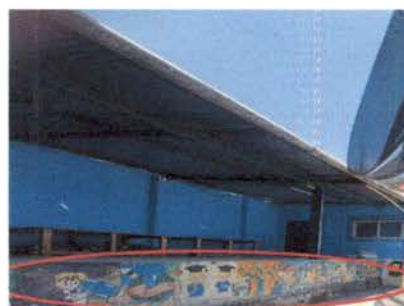
Foto 10: Reparació de pared del escenario y colocación depiso cerámico de 43 centímetros esmaltado
