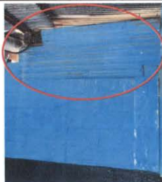
Foto 05: Levantado de pared del fondo del pasillo segundo nivel, dicha pared se levantará de block en forma triangular y su terminación será en área gris
