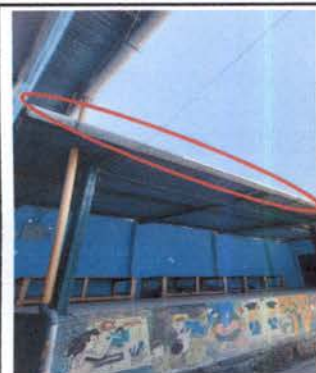
Foto 03: Sustrucción de canal de PVC en el escenario en su totalidad y cambio de forma a dos aguas se colocarán canales cuadrados de aluzinc calibre 26 con tope con su respectiva bajada
