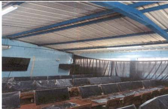
Foto 2: Mejoramiento a laboratorio de computación y dirección con cielo falso de PVC mas cornisas de PVC al perímetro. (suministro e instalación de forma inclinada. + sellado de aberturas entre costanera y troquel de lamina). revisar alineación entre costaneras para garantizar superficie uniforme en cielo falso.
