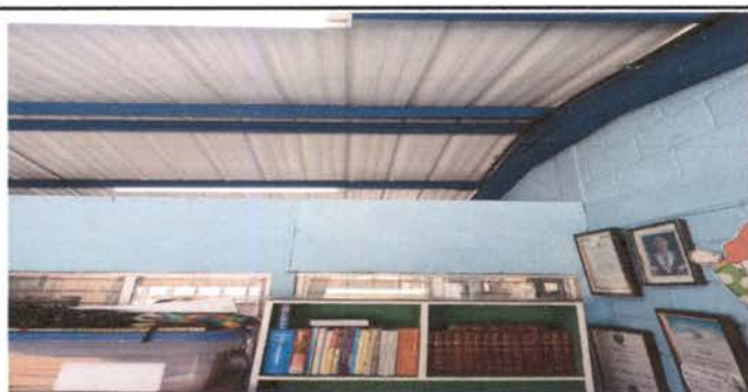
Foto 5: Mejoramiento a laboratorio de computación y dirección con cielo falso de PVC mas cornisas de PVC al perímetro. (suministro e instalación de forma inclinada. + sellado de aberturas entre costanera y troquel de lamina). revisar alineación entre costaneras para garantizar superficie uniforme en cielo falso.
