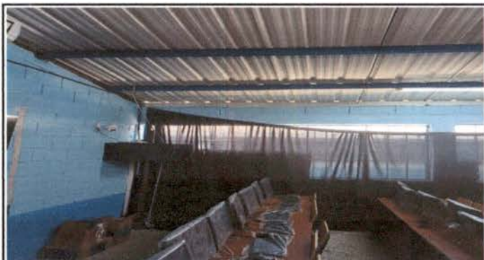
Foto 4: Mejoramiento a laboratorio de computación y dirección con cielo falso de PVC mas cornisas de PVC al perímetro. (suministro e instalación de forma inclinada. + sellado de aberturas entre costanera y troquel de lamina). revisar alineación entre costaneras para garantizar superficie uniforme en cielo falso.
