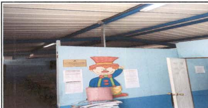
Foto 6: Mejoramiento a laboratorio de computación y dirección con cielo falso de PVC mas cornisas de PVC al perímetro. (suministro e instalación de forma inclinada. + sellado de aberturas entre costanera y troquel de lamina). revisar alineación entre costaneras para garantizar superficie uniforme en cielo falso.
