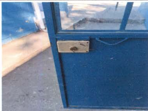
Foto 3: Sustitución de chapa yale en aula de primero primaria
