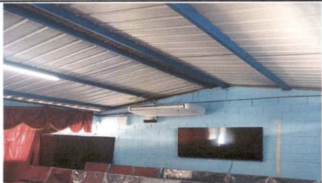
Foto1: Mejoramiento a laboratorio de computación y dirección con cielo falso de PVC mas cornisas de PVC al perímetro. (suministro e instalación de forma inclinada. + sellado de aberturas entre costanera y troquel de lamina). revisar alineación entre costaneras para garantizar superficie uniforme en cielo falso.
