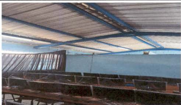
Foto 3: Mejoramiento a laboratorio de computación y dirección con cielo falso de PVC mas cornisas de PVC al perímetro. (suministro e instalación de forma inclinada. + sellado de aberturas entre costanera y troquel de lamina). revisar alineación entre costaneras para garantizar superficie uniforme en cielo falso.
