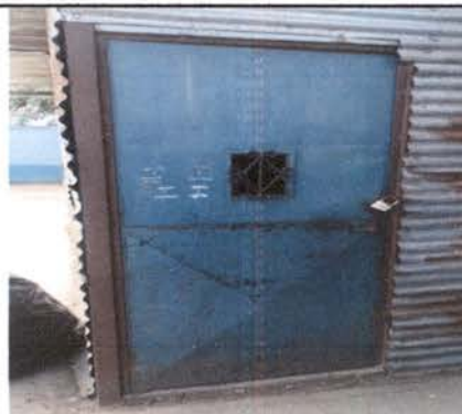
Foto 2: Sustitución de puerta en cocina
