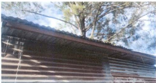
Foto 1: Suministro e instalación de lámina troquelada, aluzinc calibre 26 . En area de cocina.
