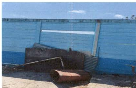
Foto 4: Reparación muro perimetral aldaño a barranco
