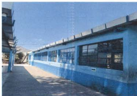
Foto 6: Reparación de canales y caidas de agua en area trasera
