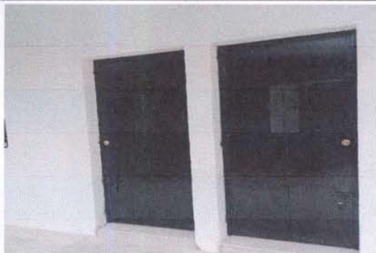
Foto 7: MANO DE OBRA ESPECIALIZADA (HERRERIA) : Fabricación e instalación de puertas de metal en aulas de Párvulos y primero B. incluye pintura.
