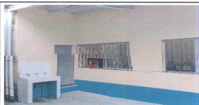
Foto 12: REPARACIÓN DE REPELLO Y CERNIDO DE PARDES: Incluye mantenimiento de paredes por mal estado, limpieza y picado de pared.
