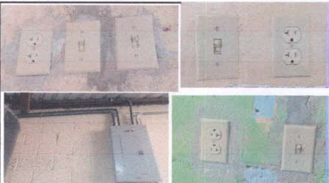
Foto 10: (ELECTRICIDAD) Instalación de unidades de fuerza (tomacorriente) incluye cable eléctrico, y conexión a tablero para individualizar la energía eléctrica para las aulas de 1ro. A, 6to, Párvulos.
