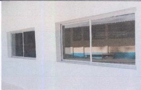
Foto 1: VENTANAS : Sustitución de estructura de metal de ventanas en Parvulos y primero B. Se instalaran ventanas de aluminio anodizado tipo corredizas, vidrio claro de 6mm. de párvulos y primero B
