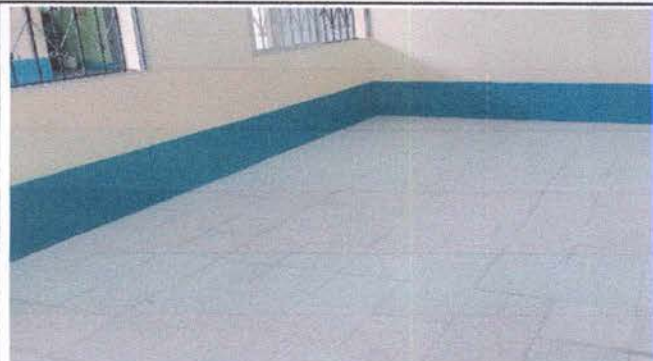
Foto 4: Sustitución de piso de torta de concreto por piso granito. Incluye levantado de torta de cemento existente, aplicación de mezcla y nivelación de suelo. En aulas de párvulos, primero B y 5to.
