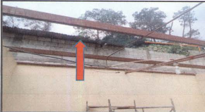
Foto 1: CUBIERTA DE LÁMINA: Sustitución de lámina, por lámina troquelada aluzinc calibre 26. en aula de párvulos y 1ro. B
