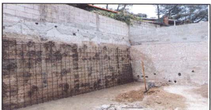
Foto 6: MUROS PERIMETRALES, REPARACION DE REPELLO Y CERNIDO DE PAREDES: Reparación de muro perimetral de block (incluye levantado de altura), Repello en muro (incluye limpieza), Cernido en muro. En aulas de párvulos y 1ro. B.
