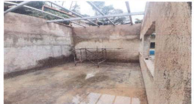
Foto 2: ESTRUCTURA DE TECHO: Mantenimiento a estructura de soporte de metal y sustitución de estructura de soporte de metal por metal, en aula de párvulos y 1ro. B
