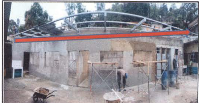
Foto 4: Sustitución de canal de metal y Sustitución de soporte o pescante de metal para canal, frente a párvulos, 1ro. B y baños. Eliminación de postes de metal.
