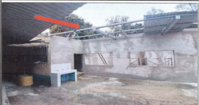
Foto 3: CANALES: instalación de canal de metal interno en el aula de 6to.
