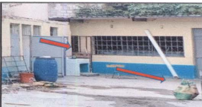
Foto 5: Reparación de bajada de agua pluvial, tubo PVC 4" que se encuentran a la par de los baños, frente a prepa y a la par de 6to.
