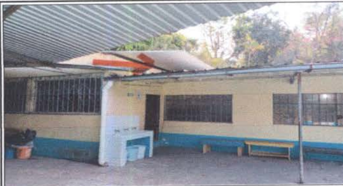
Foto 7: CANALES: instalación de canal de metal interno en el aula de 6to..B
