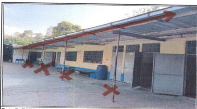
Foto 5: ESTRUCTURA DE TECHO: Sustitución de canal de metal y Sustitución de soporte o pescante de metal para canal, frente a párvulos, 1ro. B y baños. Eliminación de postes
