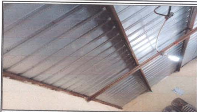
Foto 2: CUBIERTA DE LÁMINA: Sustitución de lámina, por lámina troquelada aluzinc calibre 26. en aula de párvulos y 1ro. B
