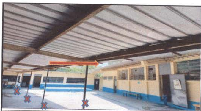
Foto 6: ESTRUCTURA DE TECHO: Sustitución de canal de metal y Sustitución de soporte o pescante de metal para canal, frente a párvulos, 1ro. B y baños. Eliminación de postes
