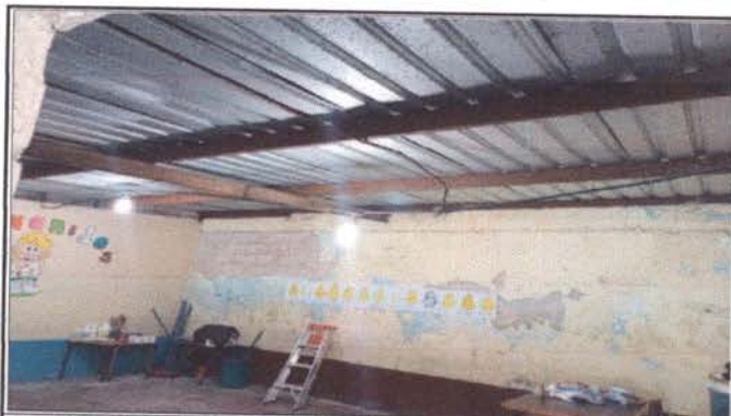
Foto 4: ESTRUCTURA DE TECHO: Mantenimiento a estructura de soporte de metal y sustitución de estructura de soporte de metal por metal, en aula de párvulos y 1ro. B
