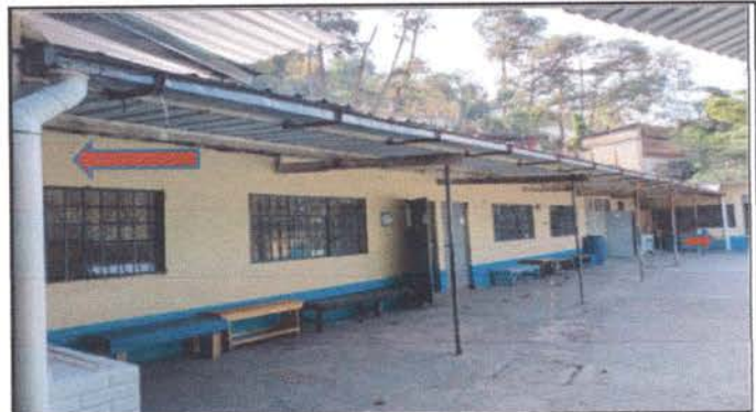
Foto 10: Reparación de bajada de agua pluvial, tubo PVC 4" que se encuentran a la par de los baños, frente a prepa y a la par de 6to.
