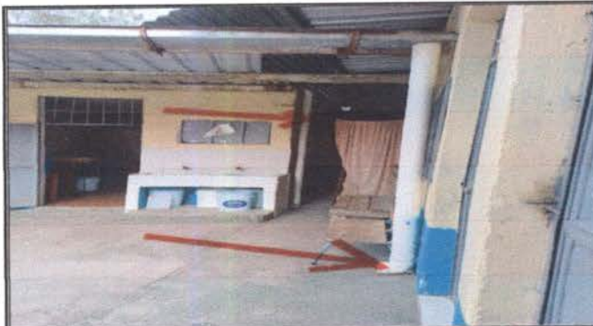
Foto 9: Reparación de bajada de agua pluvial, tubo PVC 4" que se encuentran a la par de los baños, frente a prepa y a la par de 6to.
