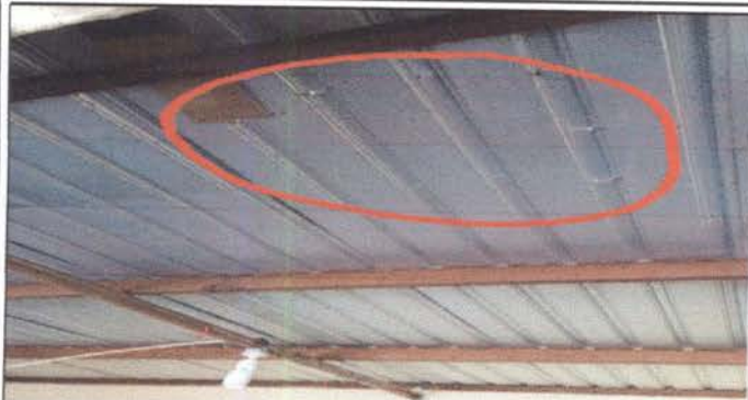
Foto 1: CUBIERTA DE LÁMINA: Sustitución de lámina, por lámina troquelada aluzinc calibre 26. en aula de párvulos y 1ro. B
