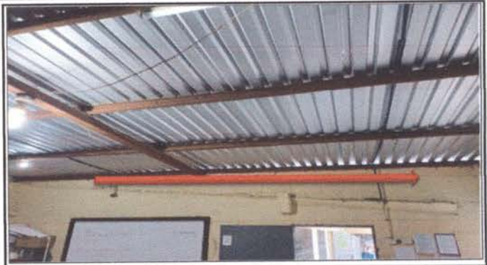
Foto 8: CANALES: instalación de canal de metal interno en el aula de 6to. B
