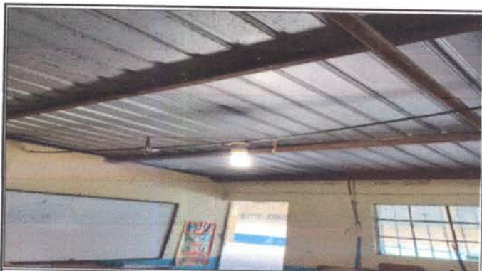
Foto 3: ESTRUCTURA DE TECHO: Mantenimiento a estructura de soporte de metal y sustitución de estructura de soporte de metal por metal, en aula de párvulos y 1ro. B
