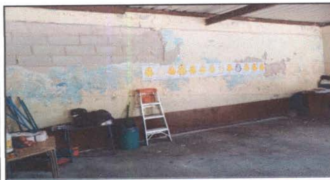
Foto 11: REPARACION DE REPELLO Y CERNIDO DE PAREDES: (Incluye mantenimiento de paredes ), Repello en muro (incluye limpieza), Cernido en muro. En aulas de párvulos y 1ro. B.
