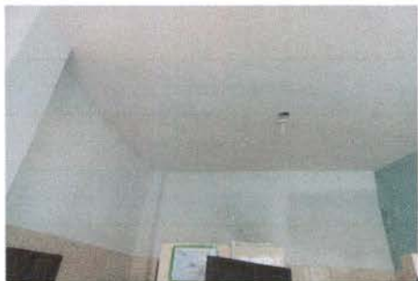
FOTO 1: APLICACIÓN DE CERNIDO Y REPELLO EN MUROS Y CIELO DE LOS SERVICIOS SANITARIOS
