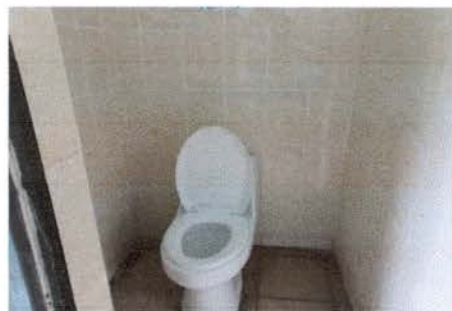
FOTO 2: SUSTITUCIÓN DE INODOROS EN SERVICIOS SANITARIOS
