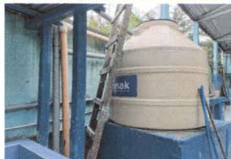
FOTO 8: INSTALACIÓN DE DEPOSITO DE AGUA
