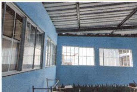
FOTO 3: INSTALACIÓN DE VENTANAS, APLICACIÓN DE REPELLO, CERNIDO Y PINTURA EN AULA DE PÁRVULOS
