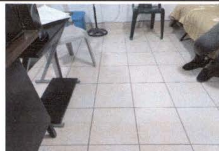
FOTO 10: INSTALACIÓN DE PISO CERÁMICO EN DIRECCIÓN
