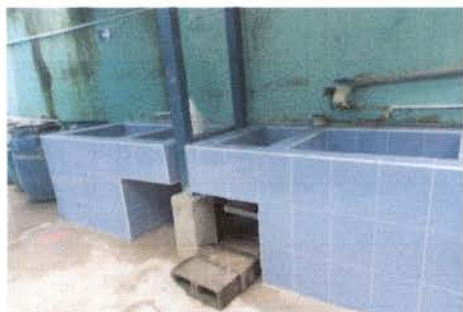
FOTO 7: INSTALACIÓN DE PILAS DE CONCRETO
