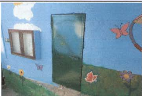
FOTO 5: INSTALACIÓN DE PUERTA NUEVA EN BODEGA
