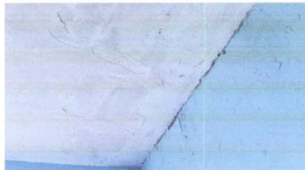
Foto 2: aplicación de cernido en loza y reparación de grietas
