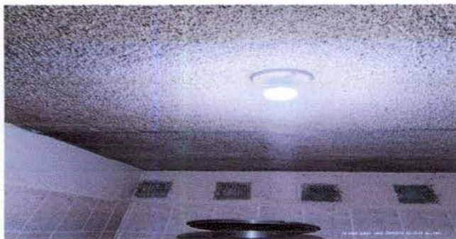
Foto1: sustición de cernido en cielo de cocina
