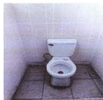
Foto 6: Sustitución de inodoros con sus accesorios en servicios sanitarios de niños y niñas.
