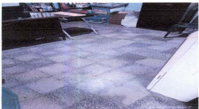
Foto 3: Sustitución de piso en área de Dirección
