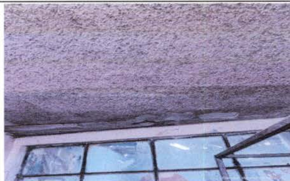
Foto 2: sellado de grietas y aplicación de cernido en loza de cocina
