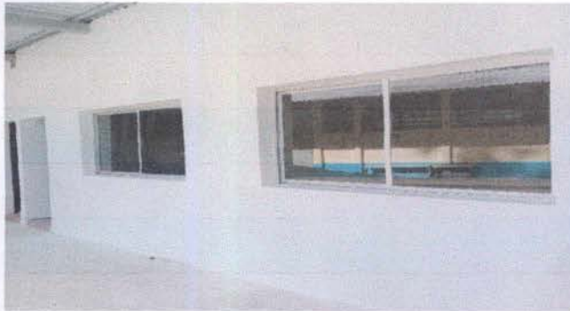
Foto1: VENTANAS : Sustitución de estructura de metal de ventanas en Parvulos y primero B. Se instalaran ventanas de aluminio anonizado tipo corredizas, vidrio claro de 6mm. de párvulos y primero B
