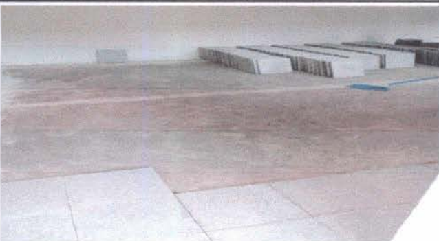
Foto 3: PISOS: Sustitución de piso de torta de concreto por piso granito. Incluye levantado de torta de cemento existente, aplicación de mezción y nivelación de suelo. En aulas de párvulos, primero B y 5to.
