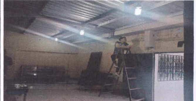
Foto 8: MANO DE OBRA ESPECIALIZADA (ELECTRICIDAD) : Instalación de unidades de iluminación con lámparas a prueba de polvo y humedad, con 2 tubos led de 18 watts (incluye interruptor, ducto y cable eléctrico)
