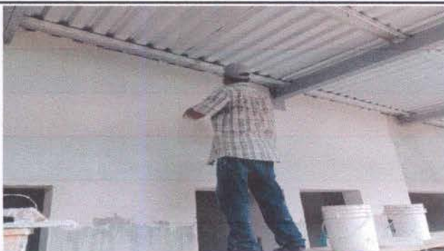
Foto 11: REPARACIÓN DE REPELLO Y CERNIDO DE PAREDES: Repello y alisado del area paredes exteriores, parvulos, primero B y paredes exteriores de baños. Incluye mantenimiento de paredes por mal estado.
