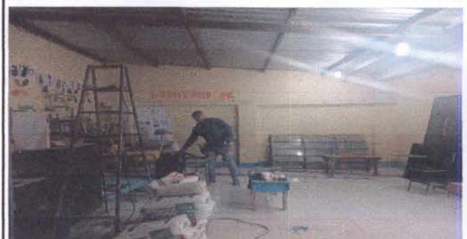
Foto 10: (ELECTRICIDAD) Instalación de unidades de fuerza (tomacorriente) incluye cable eléctrico, y conexión a tablero para individualizar la energía eléctrica para las aulas de 1ro. A, 6to, Párvulos.
