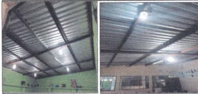
Foto 8: MANO DE OBRA ESPECIALIZADA (ELECTRICIDAD) : Instalación de unidades de iluminación con lámparas a prueba de polvo y humedad, con 2 tubos led de 18 watts (incluye interruptor, ducto y cable eléctrico) en aulas de Primero A, 6to.
