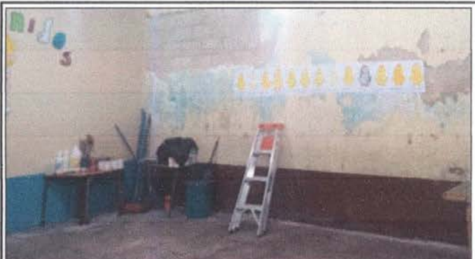
Foto 3: PISOS: Sustitución de piso de torta de concreto por piso granito. Incluye levantado de torta de cemento existente, aplicación de mezlón y nivelación de suelo. En aulas de párvulos, primero B y 5to.
