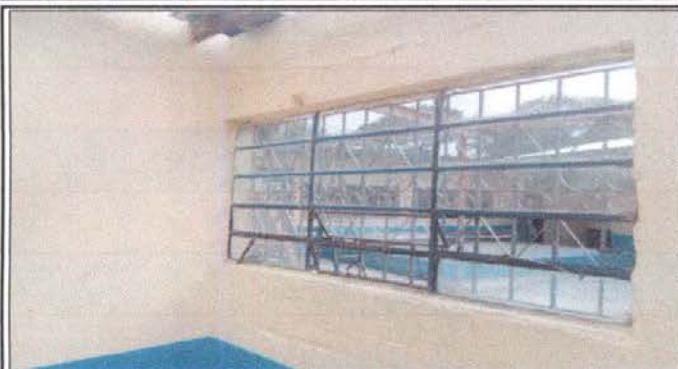
Foto1: VENTANAS : Sustitución de estructura de metal de ventanas en Parvulos y primero B. Se instalarán ventanas de aluminio anodizado tipo corredizas, vidrio claro de 6mm. de párvulos y primero B
