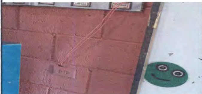
Foto: 13 sustitución de tomacorrientes dobles
