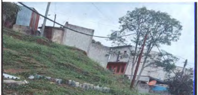
Foto 10: Sustitución de línea y ducto subterraneo
