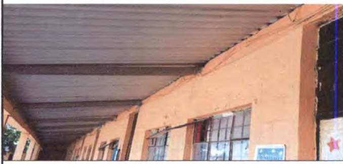
Foto 6: Sustitución de ducto electrico
