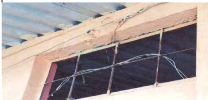
Foto 5: Reparación de sistema eléctrico
