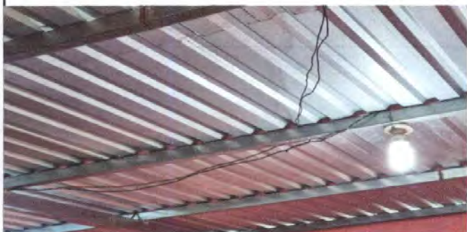
Foto 7: sustitución de lamparas led tipo liston 2x 48 base, tubo
