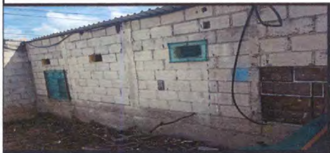
Foto1: Demolicion y tallado de vano en ventanas
