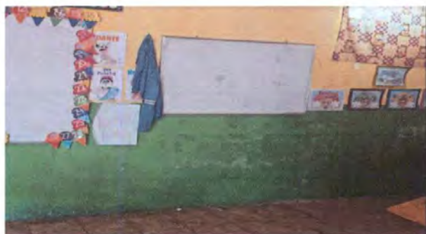
Foto 3: Tratamiento de humedad en parte externa
