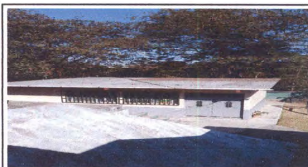
Foto 10: Sustitución de canal de PVC a canal rectangular de 20x15x240 de alto caudal aluzinc calibre 26 con pendientes en el canal en aula de 4to. Primaria Sección A
