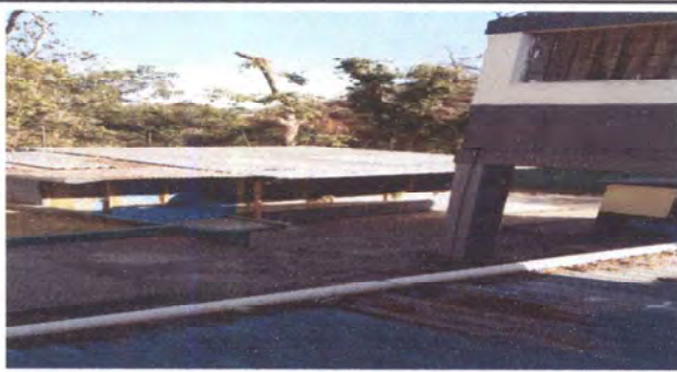
Foto 13: Sustitución de soporte de canal por pescantes de canal en el aula de 3to. Primaria Sección A
