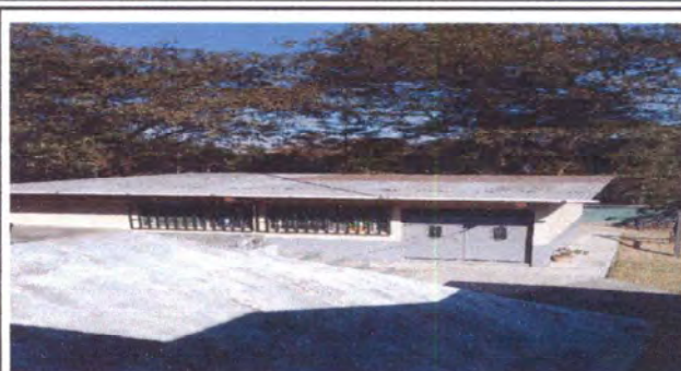
Foto 2: Sustitución de lámina de zinc acanalada que se encuentra con mucho óxido por lámina de aluzinc troquelada calibre 26 en grado de 4to. Primaria Sección A
