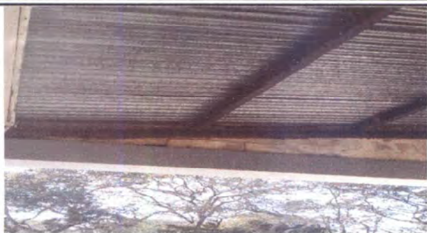
Foto 7: Mantenimiento de estructura de metal donde se colocará nueva lámina de aluzinc troquelada calibre 26, lijada con fondo gris y aplicación de pintura roja en aula de 4to. Primaria Sección B
