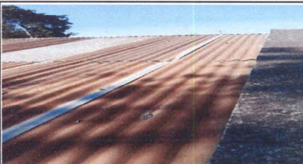
Foto 4: Sustitución de capote de lámina simple oxidado por capote de lámina calibre 26 para lámina troquelada en aula de 5to. Primaria Sección A
