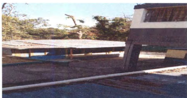
Foto 3: Sustitución de lámina de zinc acanalada que se encuentra con mucho óxido por lámina de aluzinc troquelada calibre 26 en grado de 3ro. Primaria Sección A
