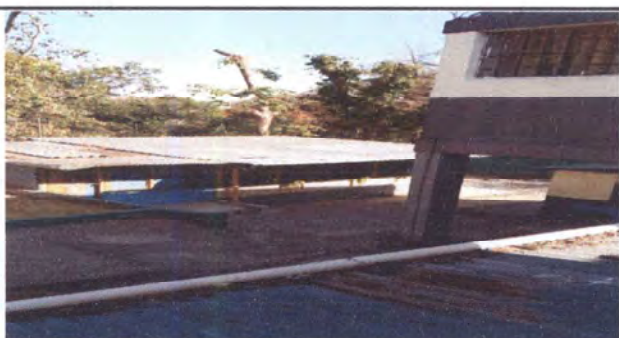
Foto 9: Mantenimiento de estructura de metal donde se colocará nueva lámina troquelada de aluzinc calibre 26, lijada con fondo gris y aplicación de pintura roja en aula de 3ro. Primaria Sección A
