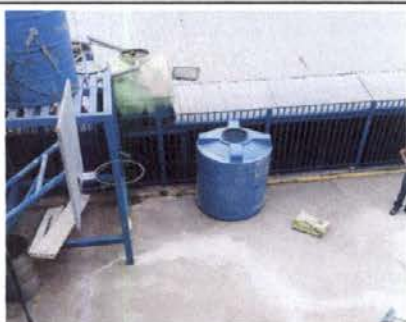
Foto 17: REPARACION Y MANTENIMIENTO DE CISTERNAS / DEPÓSITOS DE AGUA. Sustitución de depósito de agua 1,700 lts.
