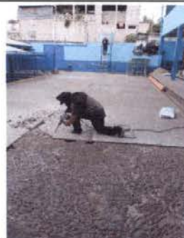
Foto 12: LOSA DE PATIO. Reparación de planchas de concreto en patio.
