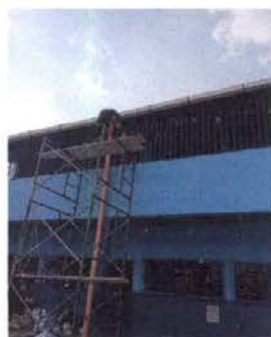
Foto 7 CANALES Y BAJADAS DE AGUA PLUVIAL. Bajada de agua pluvial tubería de 4" PVC
