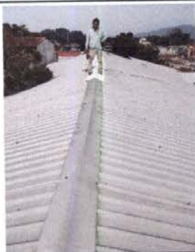
Foto 1: CUBIERTA DE LAMINA. Sustrucción de capote
