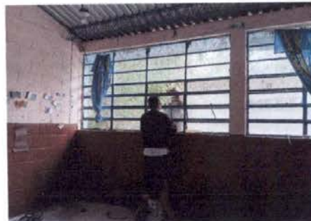
Foto 4: VENTANA. Mantenimiento al pivote de ventanas
