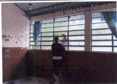
Foto 5: VENTANA. Sustrucción de vidrio de 0.18x0.70m
