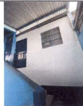
Foto 18: REPARACION DE REPELLO Y CERNIDO DE PAREDES (CUANDO APLIQUE). Aplicación de Base Gris Monocapa y acabado Blanco Monocapa en muro.
