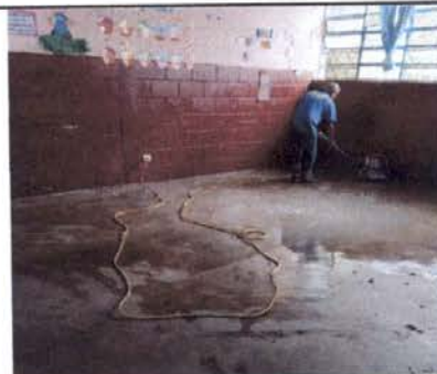
Foto 6: PISO. Reparación de piso de concreto aula segundo nivel
