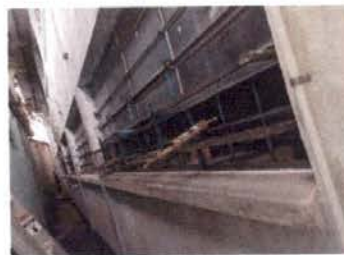
Foto 2: ESTRUCTURA DE TECHO. Sustrucción de flashing en segundo nivel
