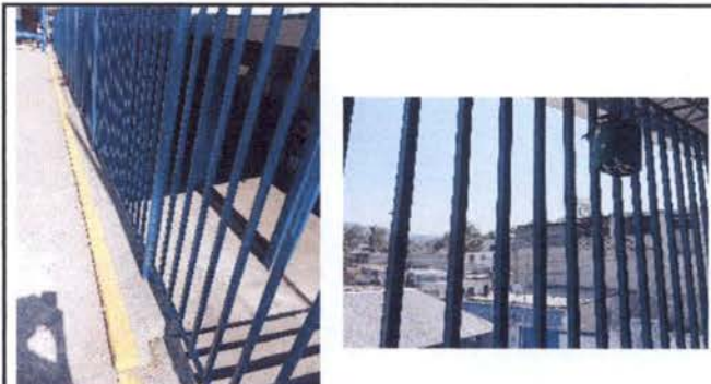
Foto 10: 11 MANTENIMIENTO A BARANDAS antenimiento a reja en área de cancha
