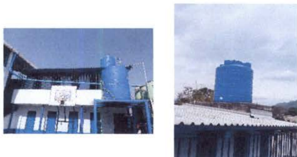
Foto 18: 18. REPARACION Y MANTENIMIENTO DE CISTERNAS / DEPÓSITOS DE AGUA. Sustitución de deposito de agua 1,700 lts.
