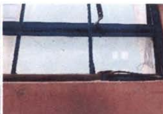
Foto 5: 5 VENTANA. Sustitución de vidrio de 0.18x0.70m
