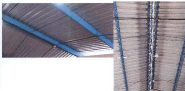
Foto1: 1. CUBIERTA DE LAMINA. Sustitución de capote
