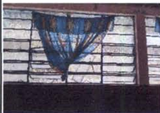
Foto 5: 5 VENTANA. Sustitución de vidrio de 0.18x0.70m
