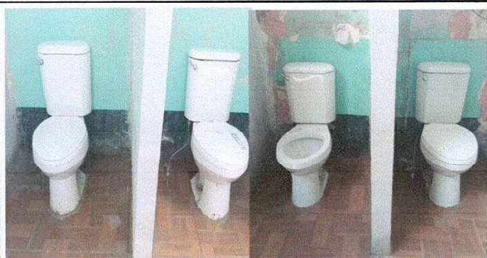
Foto 3: Sustitución de sanitarios
