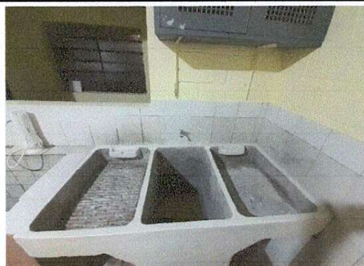
Foto 4: Sustitución de Pila
