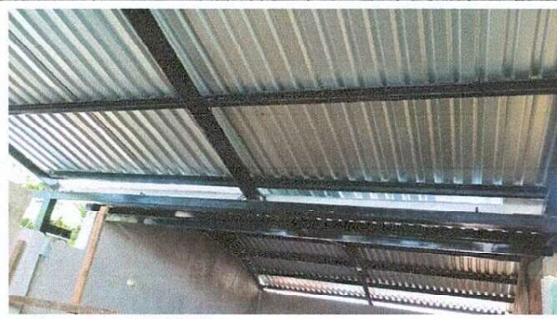
Foto 4: Cubierta de Lámina
