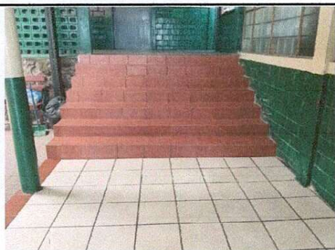
Foto 5: Sustitución de Piso en Gradas
