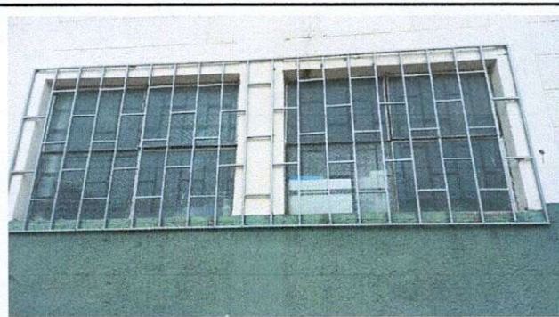
Foto 6: Mantenimiento de balcones
