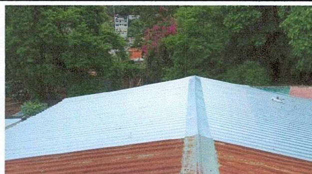
Foto: 6 Cubierta de Lámina
