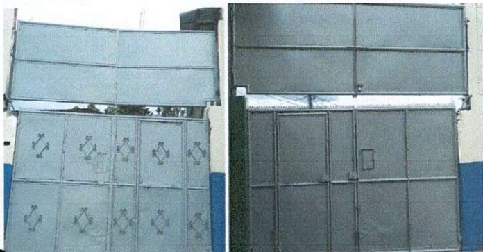
Foto 1: Mantenimiento de portón
