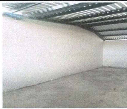
Foto: 2 Repello y Cernido de Paredes
