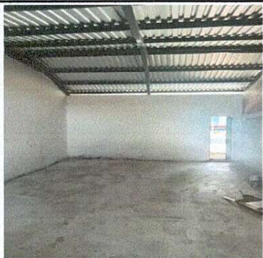
Foto1: Repello y Cernido de Paredes
