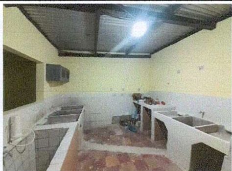
Foto.: 5 Suministro e instalación de drenaje
