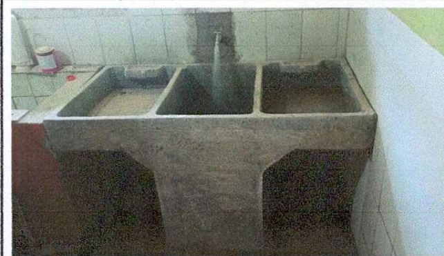
Foto 4: Sustitución de Pila
