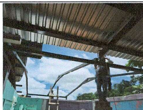
Foto: 6 Cubierta de Lámina
