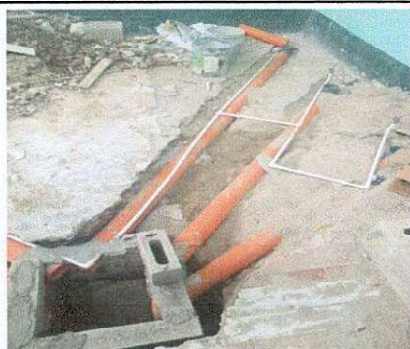
Foto.: 5 Suministro e instalación de drenaje
