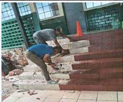
Foto 5: Sustitución de Piso en Gradas
