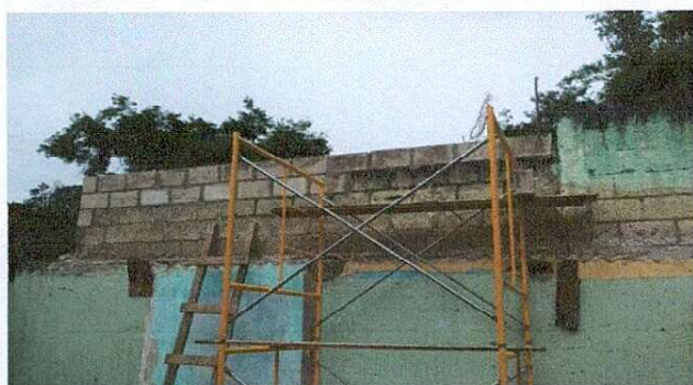
Foto1: Repello y Cernido de Paredes
