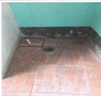
Foto 3: Sustitución de sanitarios
