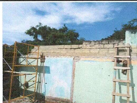
Foto 2 Repello y Cernido de Paredes
