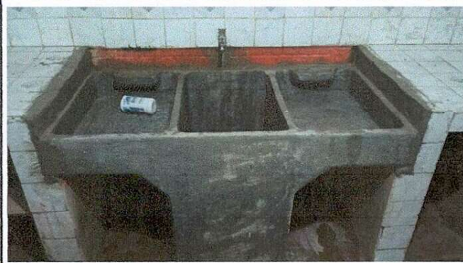
Foto 2: Sustitución de pila
