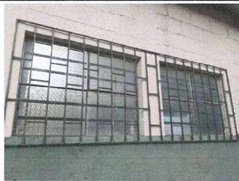
Foto 6: Mantenimiento de balcones
