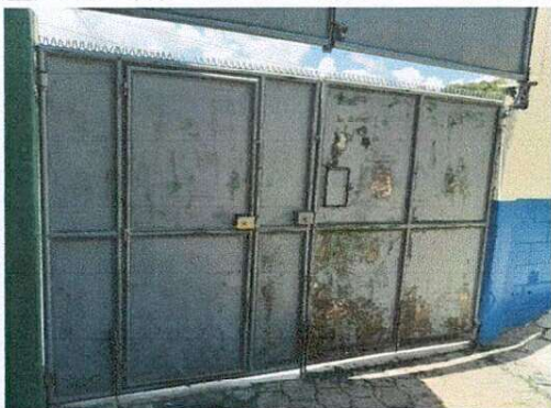
Foto 1: Mantenimiento de portón
