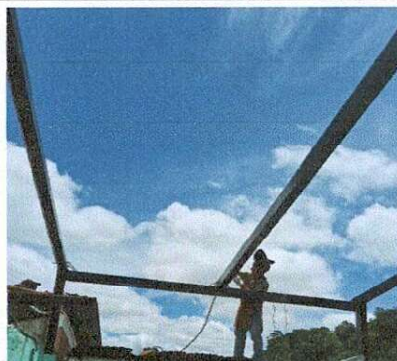
Foto 4: Cubierta de Lámina
