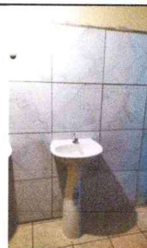
Foto 4: Lavamanos nuevo instalado
