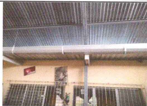
Foto 2: Instalación de canales
