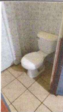
Foto 3: Azulejos y sanitarios nuevos ya instalados
