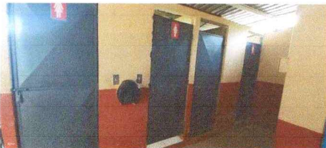
Foto 5: Instalación de puertas nuevas a sanitarios
