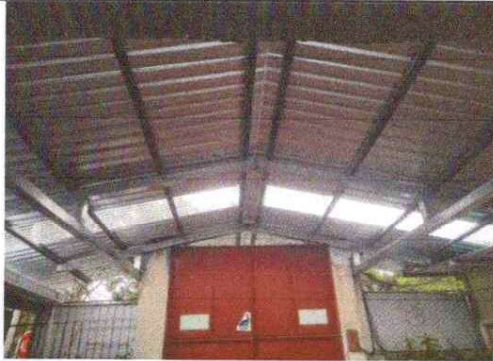
Foto1: Instalación de techo a entrada principal
