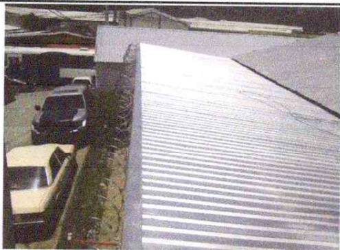
Foto 7: Techo de aulas
