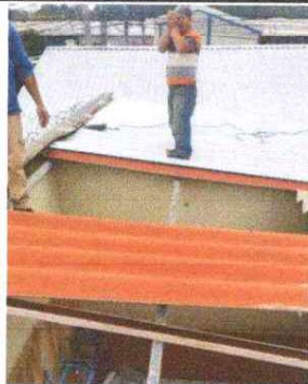
Foto1: Instalación de techo de aulas
