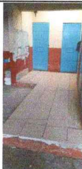
Foto 7: Mantenimiento de piso y azulejo
