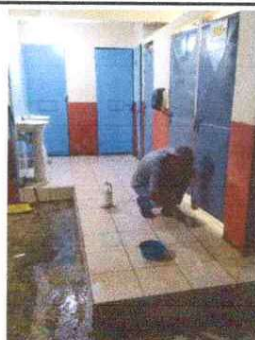
Foto 5: Desinstalación de puertas y piso en sanitarios
