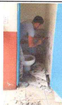
Foto 2: Instalación de azulejo en sanitarios
