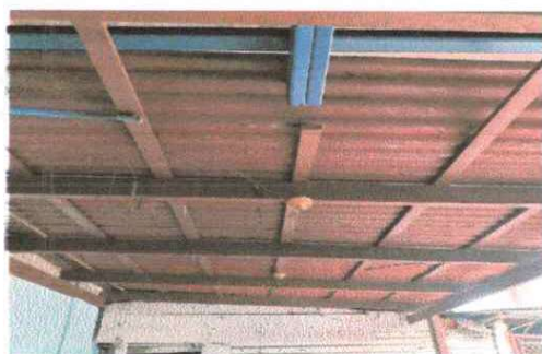
Reparacion del sistema electrico
