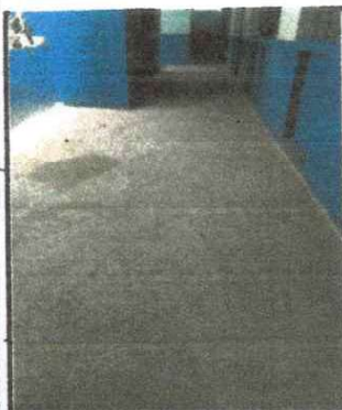
Levantamiento de piso de pasillo
