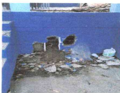
Canales y bajadas de aguas pluviales
