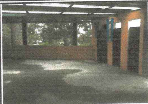
Techos, cambio de lamina y costaneras.
