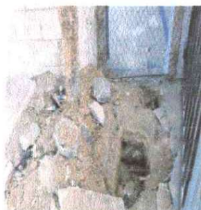
Reparaciones de red de drenajes y agua potable
