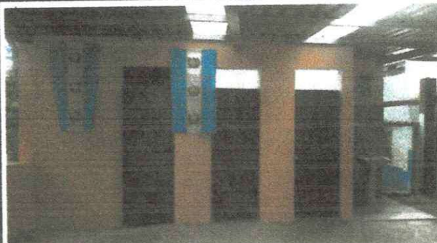
Cambio de laminado de las puertas
