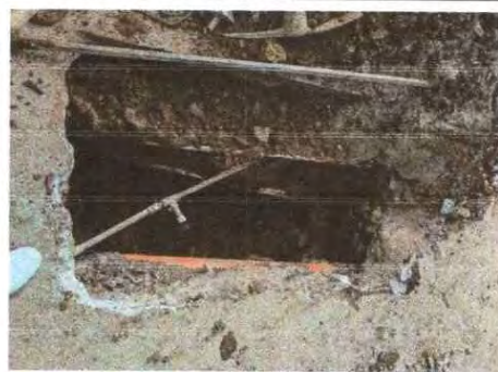
Cambio y agregar canales y bajadas de aguas pluviales
