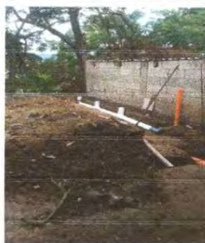
Reparacion de red de drenaje y agua potable
