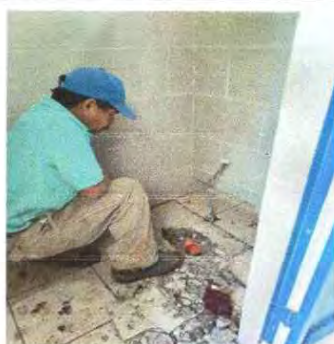
Cambio de baños y accesorios
