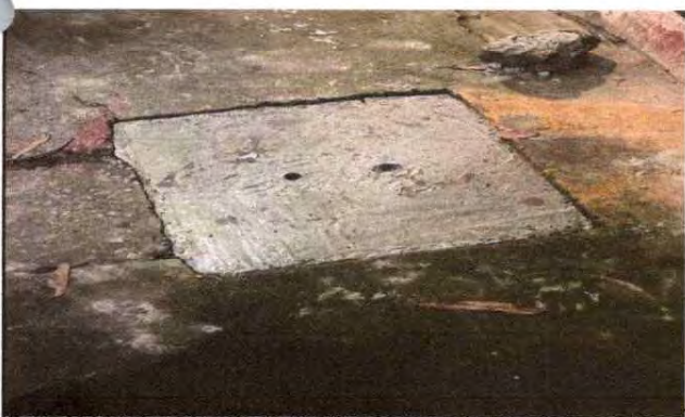
Foto. 11 Limpieza de caja de registro de agua pluvial, aguas negras, tuberías en general y hehura de tapaderas.
