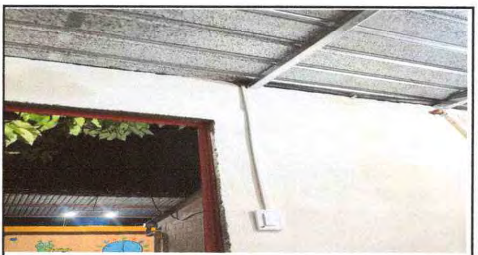
FOTO 6. Suministro y sustitución de cableado eléctrico aula, dirección 28mts (6 tomacorrientes, canaletas, plafoneras, such y abrazaderas).
