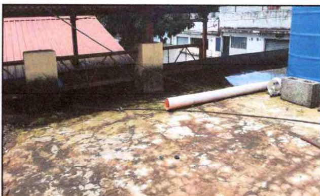
Foto 9. Mano de obra de 38m2 de mezción en terraza y aplicacion de dos manos de impermeabilizante.
