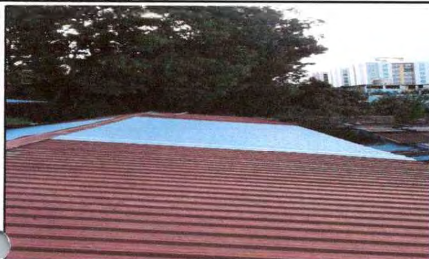
Foto 7. Sustitución de laminas .
