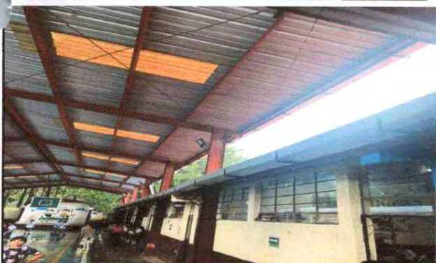
Sustitución de 186 metros de canal, retiro de canales deteriorados, pescantes, instalación de canal, adecuación de pescantes nuevos y limpieza de bajadas de canales.
