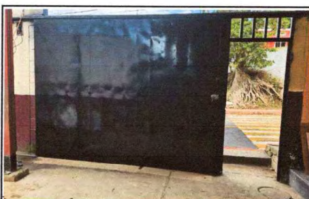
Foto 4. Reparación de portón y puerta de metal de entrada principal, cambio de rodos y reparación de 20 centímetros de altura, sustitución de 2 chapa.
