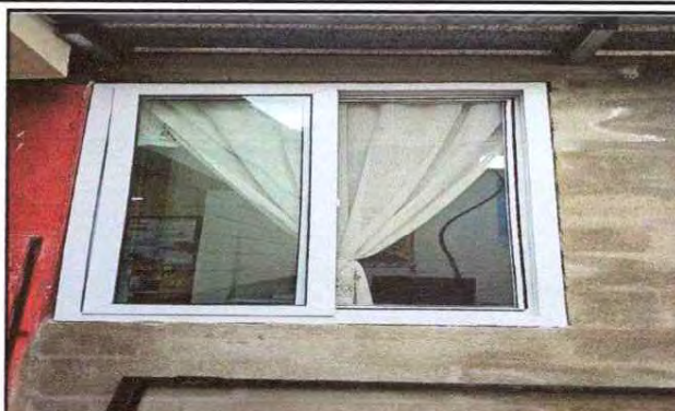
Foto 2. Sustitución ventana de PVC con mosquitero de medidas de un metro de ancho por 150 de alto,
