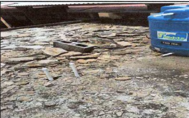
Foto 9. mano de obra de soliz de mezcla en terraza y aplicación de dos manos de impermeabilizante.
