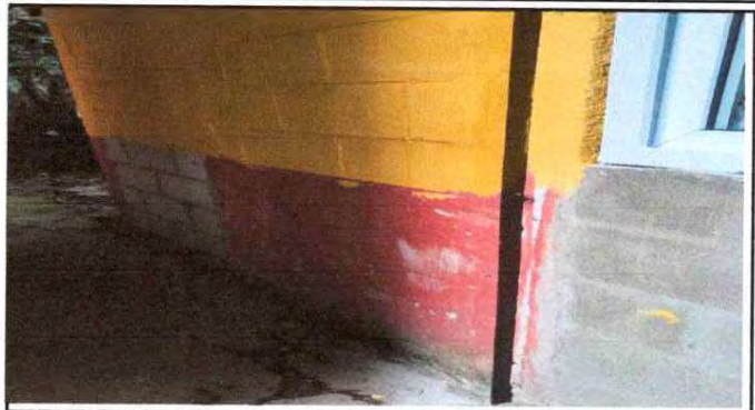
Foto 1. Suministro para pared (pintura) 2.65 alto 7.75 largo
