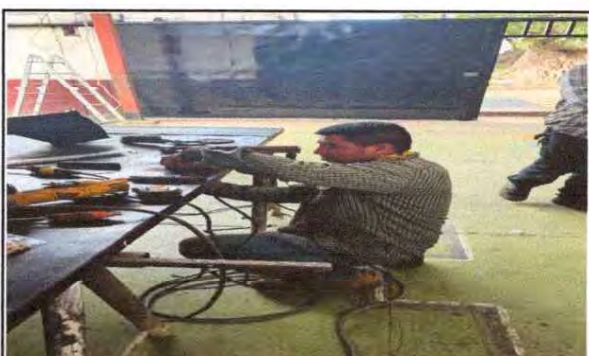
Foto. Sustitución de chapa en puerta de metal.
