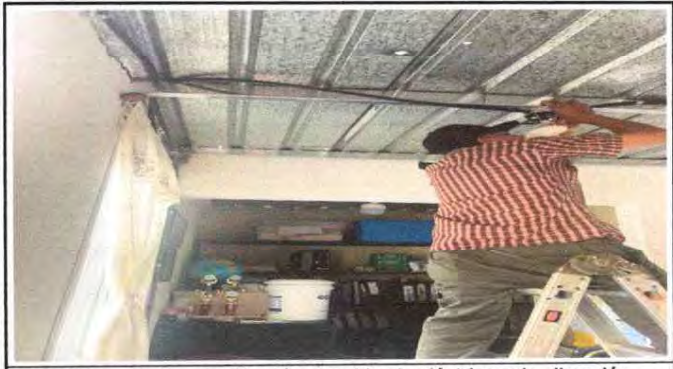
FOTO 6. Suministro y sustitución de cableado eléctrico aula, dirección 28mts (6 tomacorrientes, canaletas, plafoneras, such y abrazaderas).
