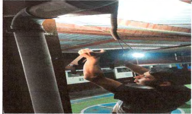
Foto 8 Sustitución de Reflectores nuevos.
