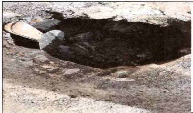
Foto. 12 Limpieza de caja de registro de agua pluvial, aguas negras, tuberías en general y hehura de tapaderas.
