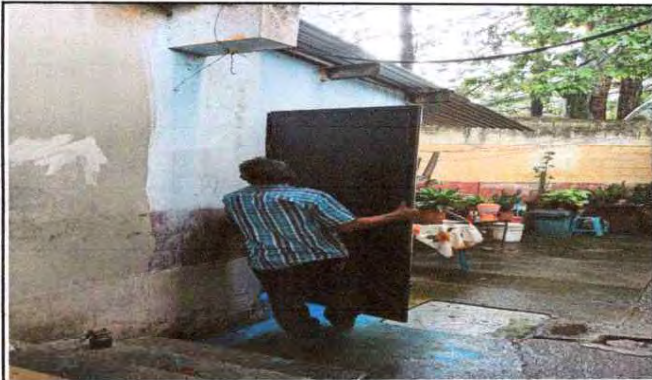
FOTO 3. Suministro y mantenimiento 2 puertas de metal (reparación y pintura).
