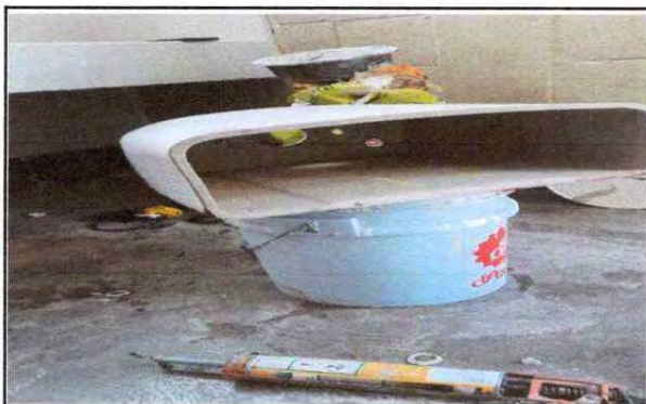
Foto 3. Sustitución de accesorios de tanques de sanitari, niples y contrallaves.
