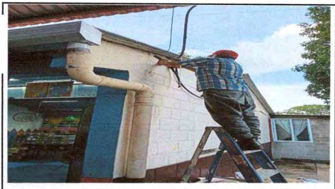
FOTO 4. Suministro y sustitución de cableado eléctrico aula, dirección 28mts (6 tomacorrientes, canaletas, plafoneras, such y abrazaderas).
