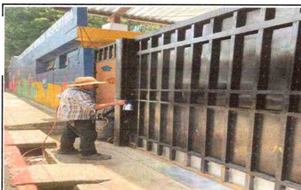
Foto 4.Reparacion de porton y puerta de metal de entrada principal, cambio de rodos y reparación de 20 centímetros de altura,sustitución de 2 chapa.
