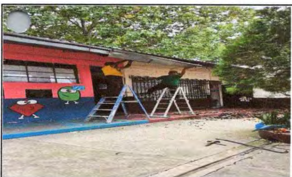
Sustitución de 186 metros de canal , retiro de canales deteriorados, pescantes, instalacion de canal , adecuación de pescantes nuevos y limpieza de bajadas de canales.
