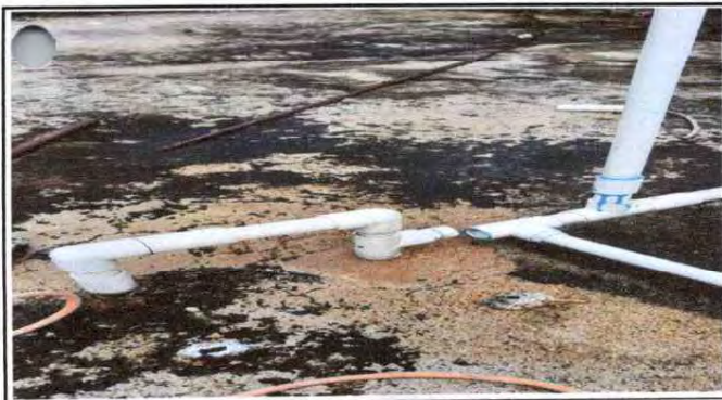
FOTO 5. Sustitución de tubería y kit de contrallave (dos depósitos de agua)
