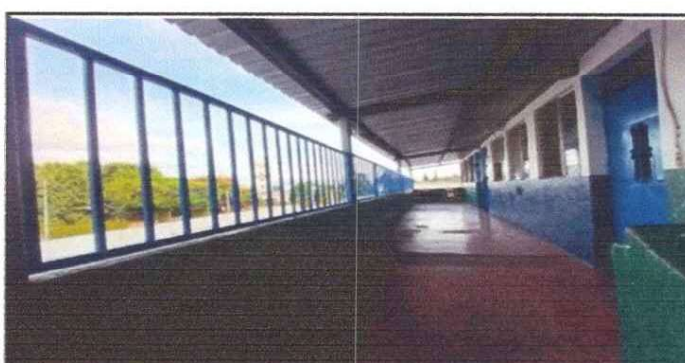
Foto 12: BARANDA DEL SEGUNDO NIVEL
