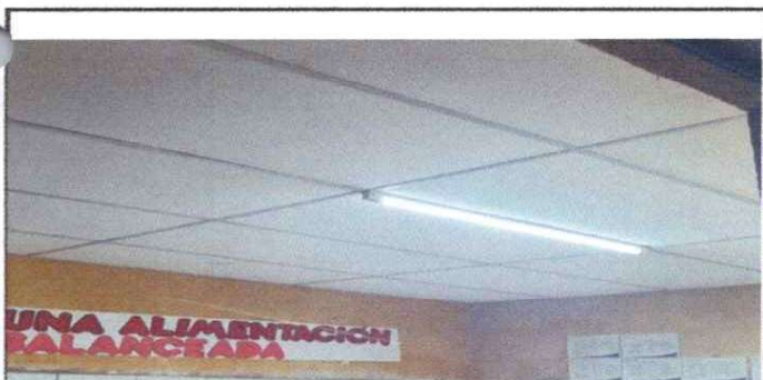
Foto 5: SUSTITUCION DE LAMPARA
