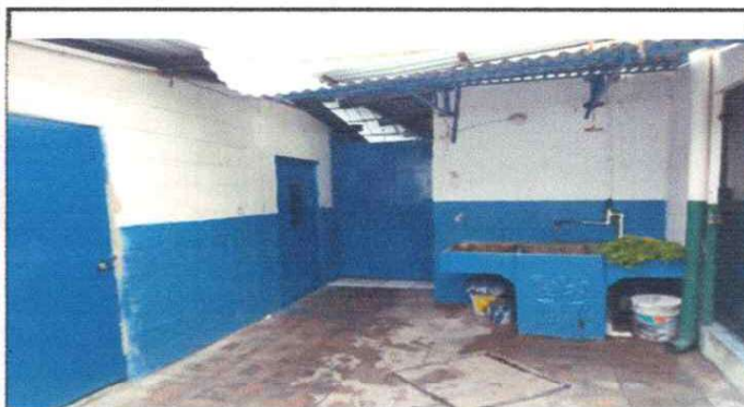
Foto 9: PUERTAS, PISO PATIO DE LA COCINA
