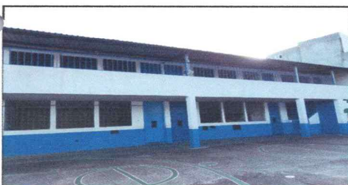
Foto 11: PUERTAS, BARANDA, REJA.
