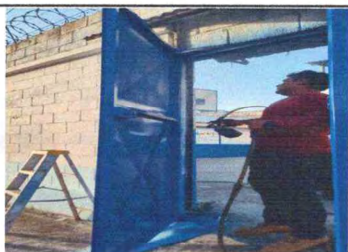
Foto 9: PORTON DEL PATIO
