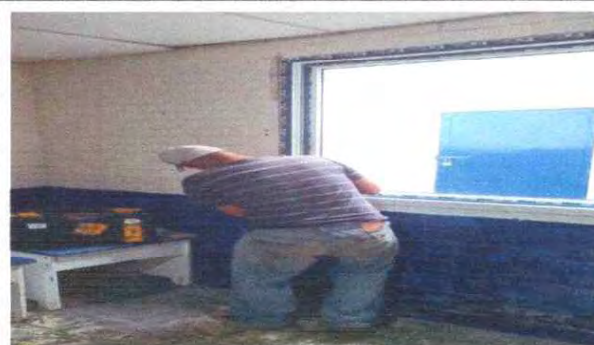
Foto 6: VENTANA DE 1ro. Y 2do.
