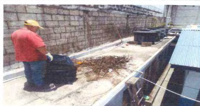
Foto 12: AREA DE IMPERMIABILIZACION
