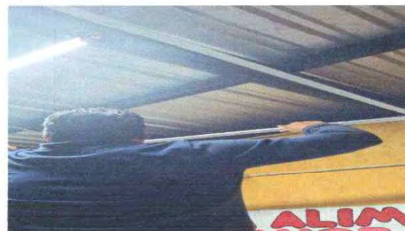
Foto 18: CIELO FALSO Y LAMPARA
