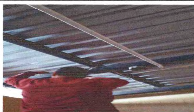
Foto 8: INSTALACION DE SISTEMA ELECTRICO COCINA
