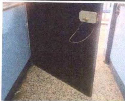
Foto 4: PUERTA CON CHAPA ELÉCTRICA, INGRESO AREA ADMINISTRATIVA, TRABAJO CONCLUIDO
