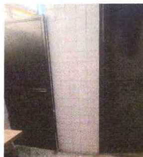
Foto 2: PUERTAS DEL INTERIOR DEL BAÑO DE CABALLEROS, TRABAJO CONCLUIDO
