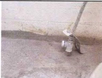
Foto 3: TRABAJO CONCLUIDO, LLAVE DE PASO EN SANITARIO DE HOMBRES CUARTO MODULO SEGUNDO NIVEL
