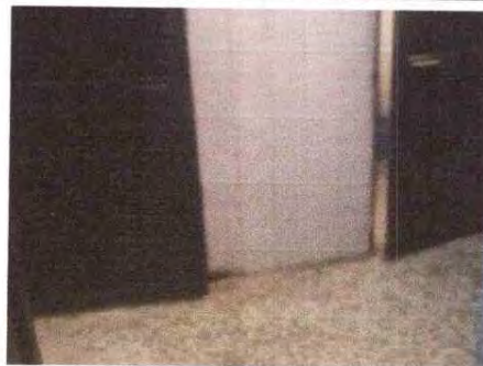
Foto 2: PUERTAS DEL INTERIOR DEL BAÑO DE CABALLEROS, TRABAJO CONCLUIDO
