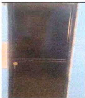
Foto 1: PUERTA SANITARIO DE CABALLEROS INGRESO COMPLETAMENTE INSTALADA
