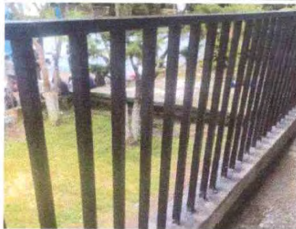
Foto1: BARANDAL DEL SEGUNDO MÓDULO, SEGUNDO NIVEL, CONCLUIDO, PINTADO, FUNDIDO Y LIMPIADO
