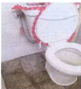
Foto 3: SANITARIO DE DAMAS DEL 2o. MÓDULO, DRENAJE CONCLUIDO
