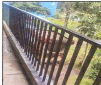
Foto 6: BARANDAL DEL 2o. MÓDULO, TUBOS FUNDIDOS Y PINTADOS, CONCLUIDO A SATISFACCIÓN.
