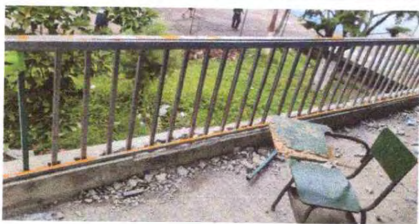
Foto 1: TRABAJO CONCLUIDO EN EL BARANDAL DEL SEGUNDO MÓDULO, SEGUNDO NIVEL
