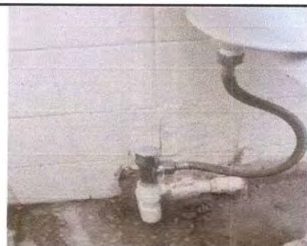
Foto 4: TRABAJO CONCLUIDO TUBERÍA Y LLAVE DE PASO SANITARIO DE BAÑO DE DAMAS SEGUNDO MÓDULO SEGUNDO NIVEL
