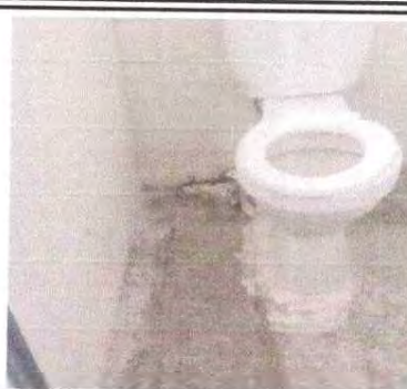
Foto 2: SANITARIO DEL CUARTO MÓDULO, TRABAJO CONCLUIDO ENTUBADO Y LLAVE DE PASO.
