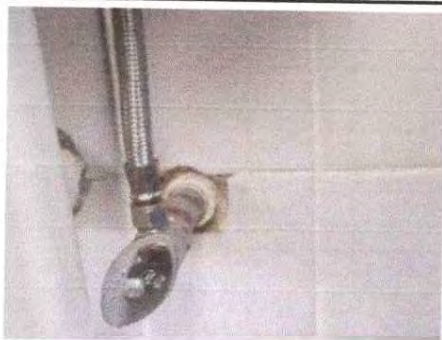
Foto 1: LLAVE DE PASO EN SANITARIO DE DAMAS DEL SEGUNDO MÓDULO SEGUNDO NIVEL, TRABAJO CONCLUIDO
