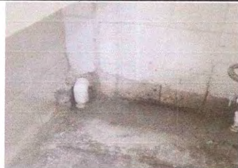
Foto 2: TRABAJO CONCLUIDO, TUBERÍA EN SANITARIO DE DAMAS 2o. MÓDULO, 2o NIVEL
