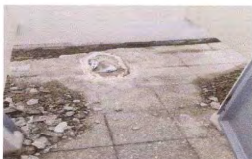
Foto 3: sustitución de tubería de agua en sanitario de damas
