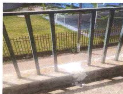
Foto 4: reparación de barandal, al lado de Escuela República de Bolivia
