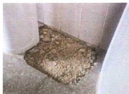
Foto 6: LEVANTADO DE PISO EN LAVAMANOS DE SANITARIO DE DAMAS DEL SEGUNDO MÓDULO SEGUNDO NIVEL
