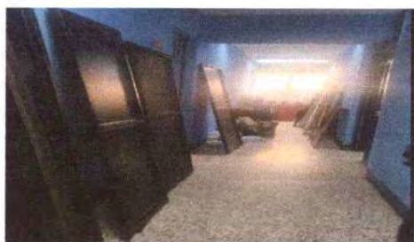
Foto 5: Inicio de colocación de puertas en el area administrativa
