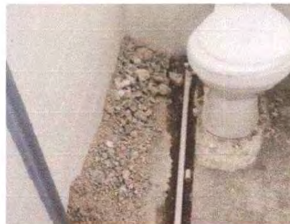
Foto 2: INSTALACIÓN DE TUBERÍA EN SANITARIO DE VARONES EN EL CUARTO MÓDULO SEGUNDO NIVEL
