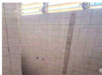
Foto 2: INICIANDO EL PROCESO PARA INSTALAR PUERTAS METÁLICAS EN SANITARIO DE VARONES AREA ADMINISTRATIVA
