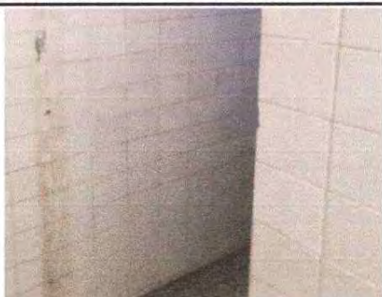
Foto 1: INICIANDO EL PROCESO PARA INSTALAR PUERTAS METÁLICAS EN SANITARIO DE VARONES AREA ADMINISTRATIVA
