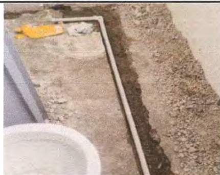
Foto 3: INSTALANDO TUBERÍA DE AGUA POTABLE EN SANITARIOS DE VARONES DEL CUARTO MÓDULO SEGUNDO NIVEL
