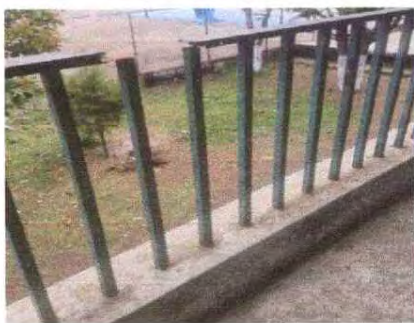
Foto 1: INSTALANDO LOS PRIMEROS TUBOS DE BARANDAL DEL SEGUNDO MÓDULO SEGUNDO NIVEL
