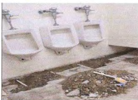
Foto 1: Reparación de tubería de abastecimiento de agua a sanitarios, del 2o módulo 2o. Nivel sanitario de varones.
