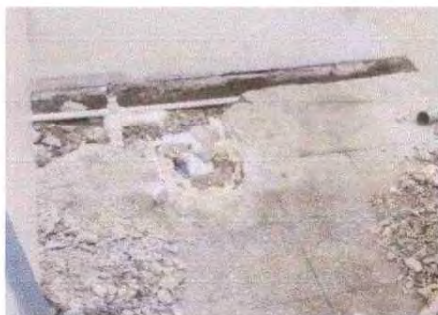
Foto1: INSTALANDO TUBERÍA EN SANITARIO DE VARONES DEL CUARTO MÓDULO SEGUNDO NIVEL
