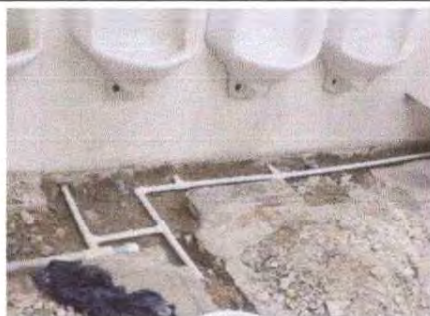
Foto 5: INSTALANDO TUBERÍA EN MINGITORIOS DE SANITARIO DE VARONES DEL SEGUNDO NIVEL CUARTO MÓDULO
