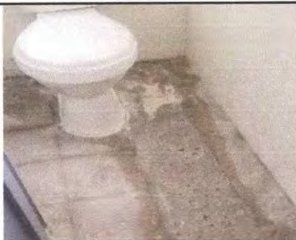
Foto 3: LEVANTADO DE PISO PARA REPARACIÓN DE LA TUBERÍA DE AGUA POTABLE QUE SURTE EL SANITARIO DEL 4o MÓDULO 2o NIVEL
