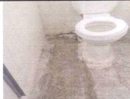
Foto 4: LEVANTADO DE PISO PARA REPARACIÓN DE TUBERÍA DE AGUA POTABLE QUE SURTE EL SANITARIO DEL 2o MÓDULO 2o NIVEL
