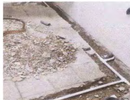
Foto 4: INSTALANDO TUBERÍA DE AGUA POTABLE PARA SANITARIOS DE DAMAS EN EL SEGUNDO MÓDULO SEGUNDO NIVEL
