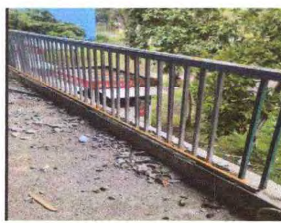
Foto 2: reparación de barandales en el segundo modulo y segundo nivel, lado de area verde
