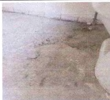
Foto 2: LEVANTADO DE PISO PARA REPARACIÓN DE TUBERÍA DE AGUA POTABLE EN SANITARIO DEL SEGUNDO MÓDULO SEGUNDO NIVEL
