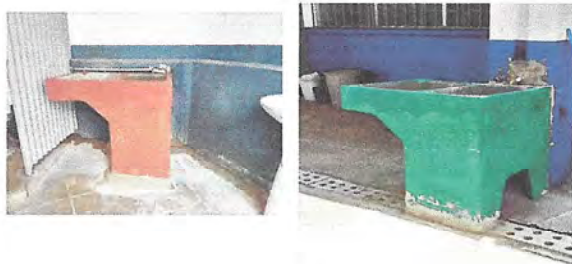
Foto 3: Sustitución, suministro e instalación de pila de cemento de un lavadero (área preprimaria y patio principal primaria)
