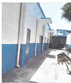
Foto1: Sustrucción, Suministros e instalación de siete bajadas agua pluvial , tubo pvc 4"80 psi
