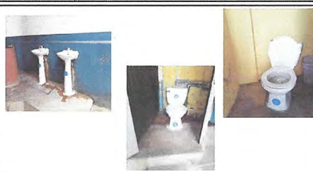
Foto 2: Sustitución, Suministro e instalación de 2 servicios sanitarios, lavamanos y accesorios (área de preprimaria)
