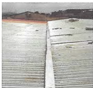
Foto 5: Sustitución, e instalación de canal de metal, incluye pescantes.
