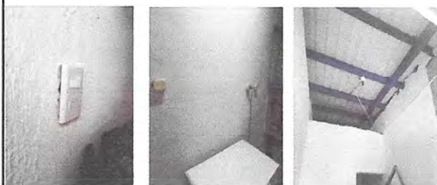
Foto 5: Suministro y sustitución de unidad luminaria+ interruptor (bodega de alimentos, cocina y un sanitario jornada matutina)
