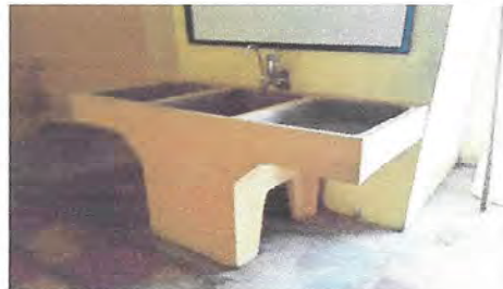
Foto 2: Sustitución, suministro e instalación de pila de cemento de dos lavaderos (cocina jornada vespertina)
