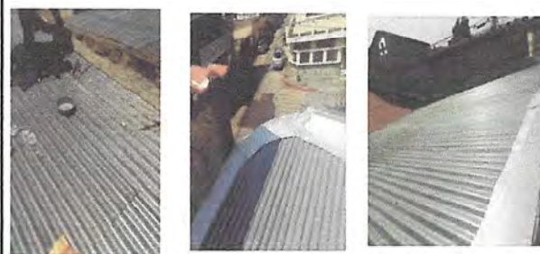
Foto 6: Readecuación de estructura de techo y desmontaje de lámina existente para instalación de Flashing de lámina de aluzinc calibre 26. remozamiento de pared y sellado en orilla de lámina en módulo de
