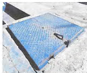
Foto 2: Mantenimiento a tapadera de cisterna de 40 x 40 cms.( se fijo con soldadura)
