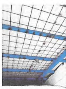
Foto 3: Suministro e instalación de malla electrosoldada 6x6 calibre 4.5 / 4.5 en techo bodega de alimentos (de 6 largo X 2.30 mts. de ancho, jornada matutina)
