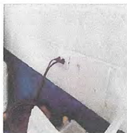
Foto 4: Suministro y sustitución de cableado eléctrico (bodega de alimentos, cocina y sanitario jornada matutina)
