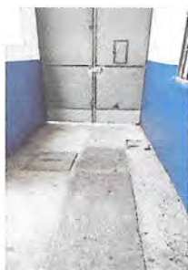
Foto1: Mantenimiento a parte inferior de portón principal de 1.25 mts. de ancho X 30 cm. de largo. (lijado y pintado de dos manos).
