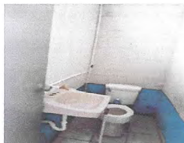
Foto 4: Sustitución, Suministro e Instalación de tubería lineal para un lavadero y sanitario, en dirección jornada vespertina.
