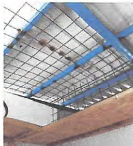
Foto 3: Suministro e instalación de malla electrosoldada 6x6 calibre 4.5 / 4.5 en techo bodega de alimentos (de 6 largo X 2.30 mts. de ancho, jornada matutina)
