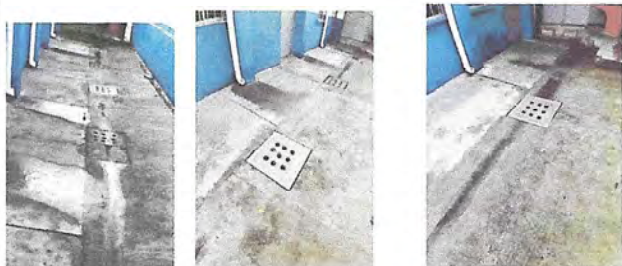
Foto1: Suministro e instalación de dos reposaderas, zanjeado, tallado, elaboración de dos piezas de tapaderas ( área patio de preprimaria)
