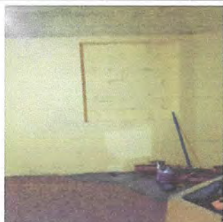
Foto 5: Suministros e instalación de repello de 2 mts2 de cocina (jornada vespertina)
