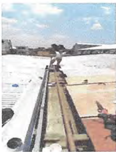
Foto 5: Sustitución, e instalación de canal de metal, incluye pescantes.
