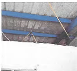
Foto 3: Suministro e instalación de malla electrosoldada 6x6 calibre 4.5 / 4.5 en techo bodega de alimentos (de 6 largo X 2.30 mts. de ancho, jornada matutina)
