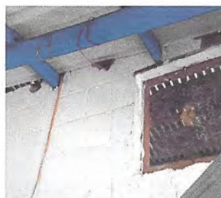
Foto 4: Sustitución, Suministros e instalación de 1/2 mt2 de levantado de pared en bodega de alimentos (jornada matutina)
