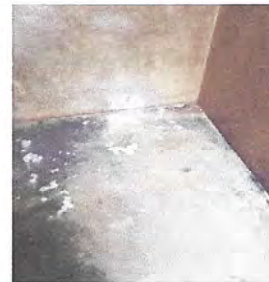
Foto 2: Suministro y aplicación de impermeabilización, sellado de fisuras y resanante de cisterna de concreto de 2.80 largo x 2.50 de ancho x 1.80 de alto ( vaciado, revisión general interna antes de impermeabilización)
