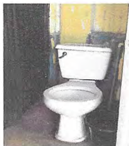
Foto1: Sustrucción de 8 accesorios inodoro (contra llave, tubo de abasto y tanque), área de primaria
