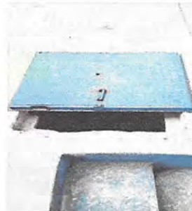
Foto 2: Mantenimiento a tapadera de cisterna de 40 x 40 cms.( se fija con soldadura)
