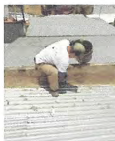
Foto 6: Readecuación de estructura de techo y desmontaje de lámina existente para instalación de Flashing de lámina de aluzinc calibre 26. remozamiento de pared y sellado en orilla de lámina en módulo de
