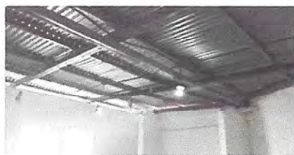
Foto 3: Suministro y sustitución de bombilla led (para doce aulas)
