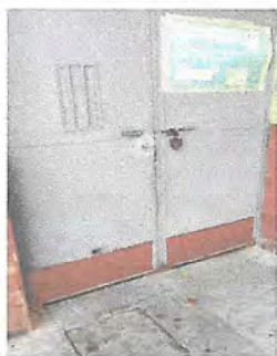
Foto1: Mantenimiento a parte inferior de portón principal de 1.25 mts. de ancho X 30 cm. de largo. (lijado y pintado de dos manos).
