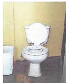
Foto 2: Sustrucción, Suministro e instalación de 2 servicios sanitarios, lavamanos y accesorios (área de preprimaria)
