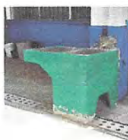
Foto 3: Sustitución, suministro e instalación de pila de cemento de un lavadero (área preprimaria y patio principal primaria)
