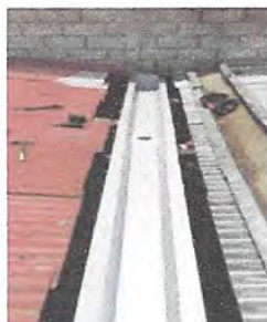
Foto 5: Sustitución, e instalación de canal de metal, incluye pescantes.
