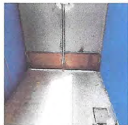
Foto1: Mantenimiento a parte inferior de portón principal de 1.25 mts. de ancho X 30 cm. de largo. (lijado y pintado de dos manos).
