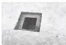
Foto1: Suministro e instalación de dos reposaderas, zanjeado, tallado, elaboración de dos piezas de tapaderas ( área patio de preprimaria)
