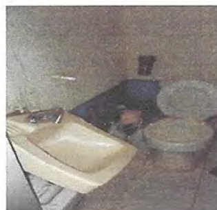
Foto 4: Sustrucción, Suministro e instalación de tubería lineal para un lavadero y sanitario, en dirección jornada vespertina.
