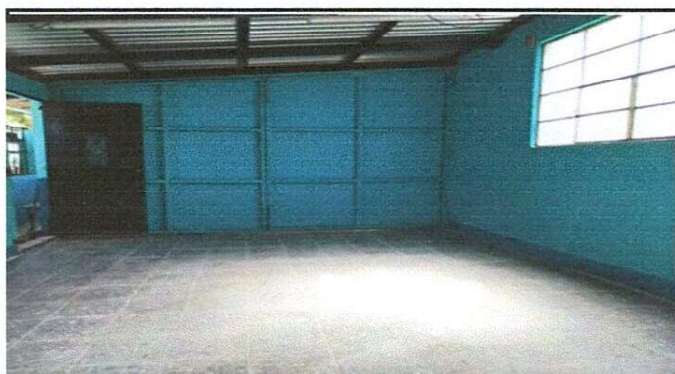
Foto 4: Instalación de piso en primer aula del segundo nivel.
