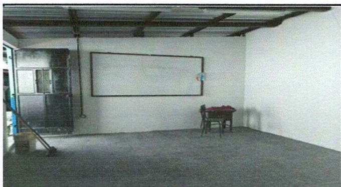
Foto 3: Repello de aulas del segundo nivel.
