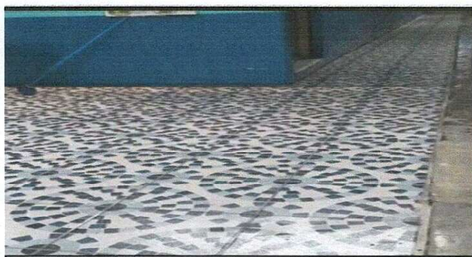
Foto 5: Instalación de piso en corredor
