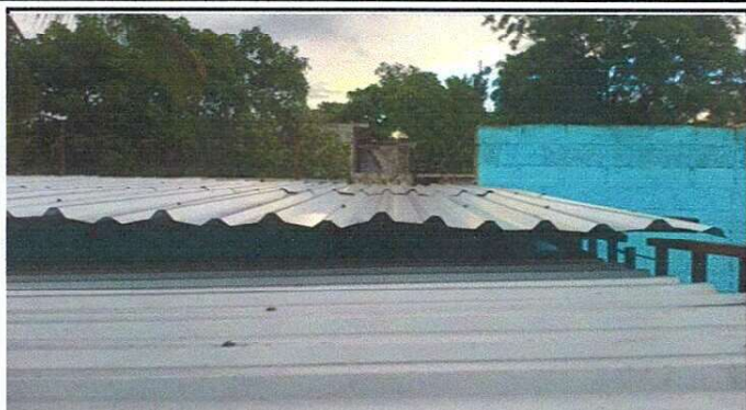
Foto1: Cambio de lamina a troquelada.
