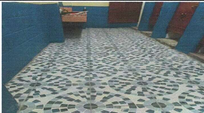
Foto 2: Instalación de piso en baño.
