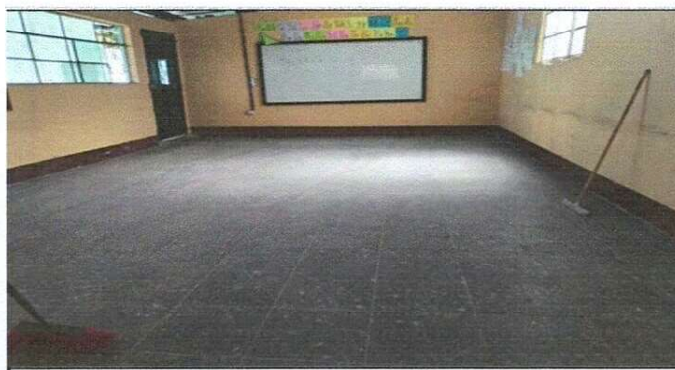
Foto 6: Instalación de piso en segunda aula del segundo nivel.
