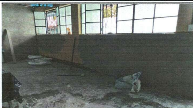
Foto 2: Aplicación de monocapa de primer aula segundo nivel.
