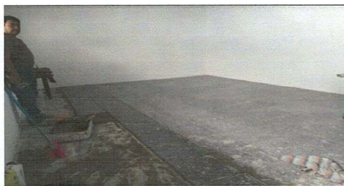
Foto 6: Instalación de piso en aulas del segundo nivel.
