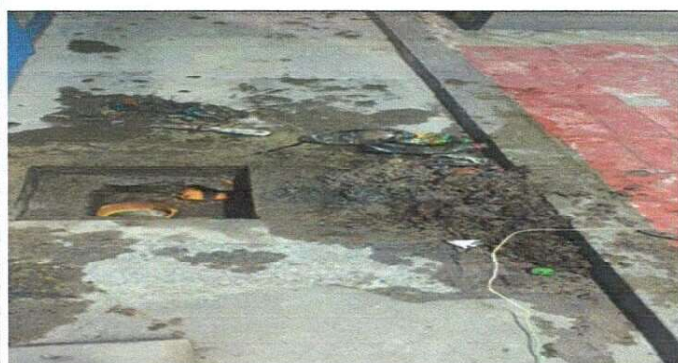
Foto 5: Mantenimiento y Limpieza de drenaje.
