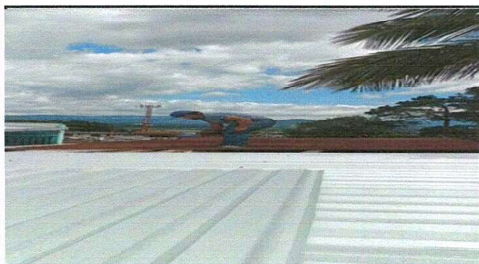
Foto 3: Cambio de lámina en dos bodegas.
