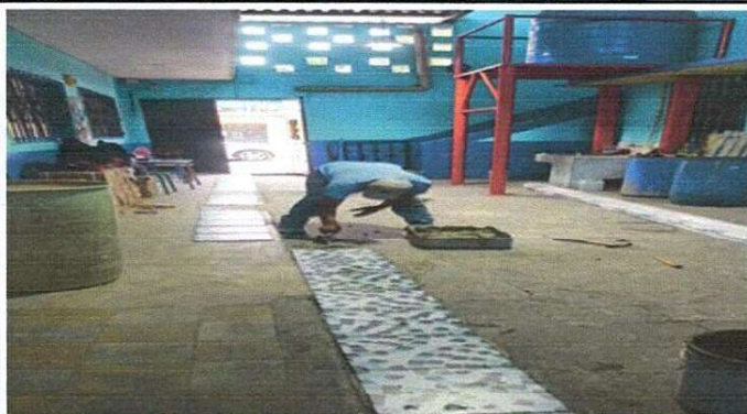
Foto1: Piso en corredor y baño
