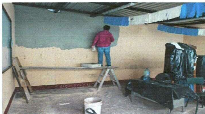
Foto 4: Aplicación de monocapa en segunda aula del segundo nivel.
