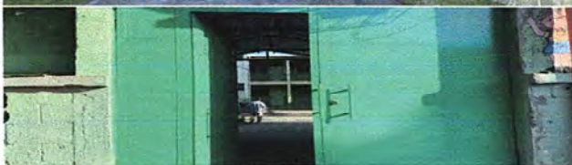
Foto: 1 CAMBIO DE PORTÓN
