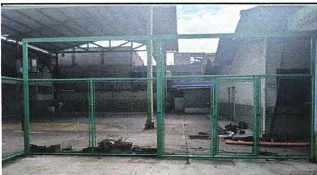
Foto: 3 PORTÓN Y CERCO ÁREA DE PREPRIMARIA
