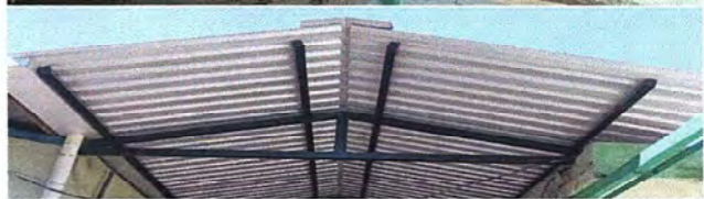
Foto: 2 INSTALACIÓN DE ESTRUCTURA DE TECHO DE ENTRADA DE LA ESCUELA
