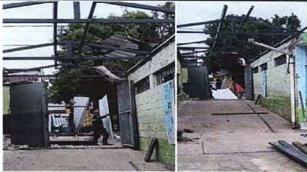
Foto: 1 CAMBIO DE PORTÓN
