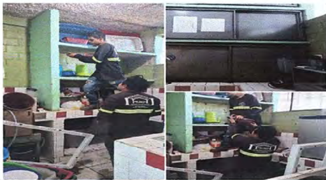
Foto: 4 PUERTAS DE GABINETES DE COCINA
