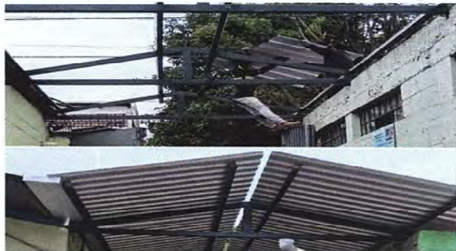
Foto: 2 INSTALACIÓN DE ESTRUCTURA DE TECHO DE ENTRADA DE LA ESCUELA
