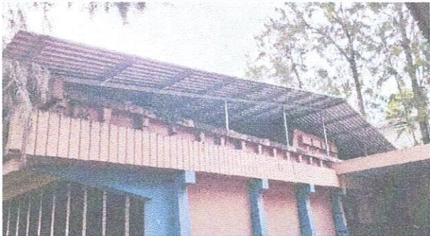
Vista frontal área de laminado terminado.
