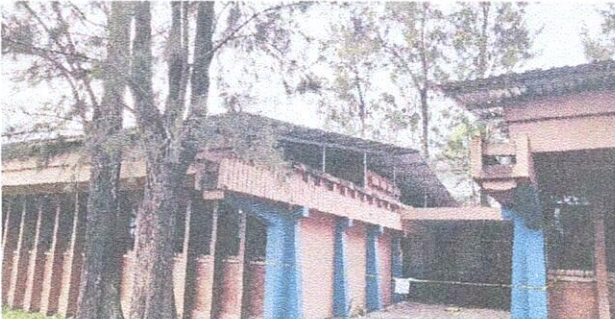
Vista área de laminado terminado.
