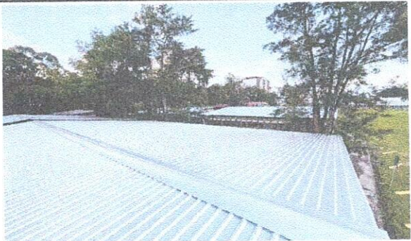
Área en donde se está instalando el laminado.
