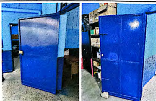
Foto 5: Mantenimiento de puertas, incluye lijado y pintura.
