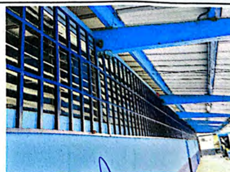
Foto 6: Mantenimiento de balcones, incluye lijado y pintura.
