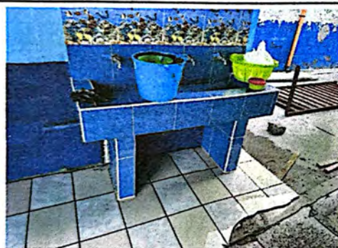
Foto 3: Fabricación de pileta.
