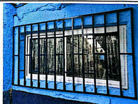
Foto 4: Suministro e instalación de ventana de UPVC.
