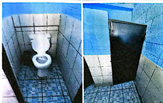
Foto 1: Instalación de inodoros + piso + mantenimiento a puerta y aplicación de pintura en baño de niños.
