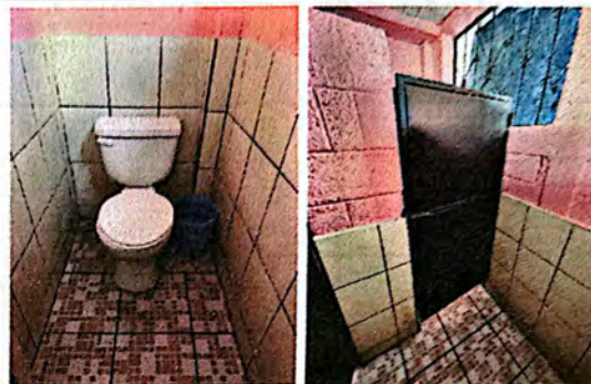
Foto 2: Instalación de inodoros + piso + mantenimiento a puerta y aplicación de pintura en baño de niñas.
