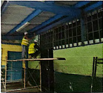
Foto 1: Mantenimiento a Balcones.
