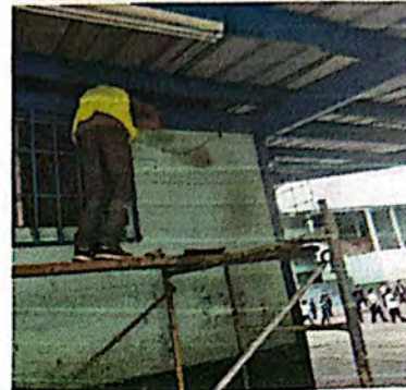
Foto 2: Mantenimiento a Balcones.
