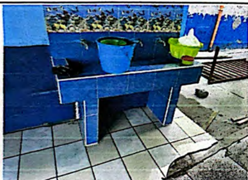
Foto 9: Construcción de pileta tipo lavamanos.
