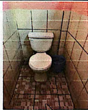
Foto 6: Suministro e instalación de baño + Piso antideslizante.
