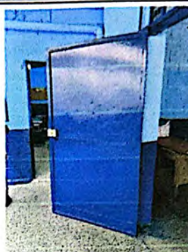
Foto 8: Mantenimiento a puertas de ingreso.
