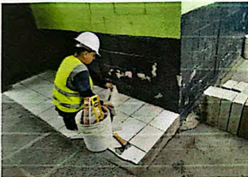
Foto 3: Preparación de área para construcción de pileta.
