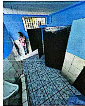
Foto 4: Suministro e instalación de piso antideslizante en baños.
