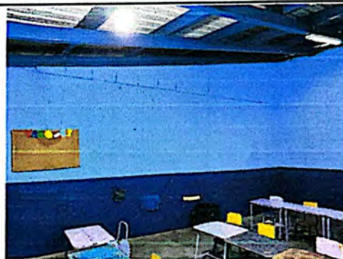
Foto 10: Suministro y aplicación de pintura en muros interiores.
