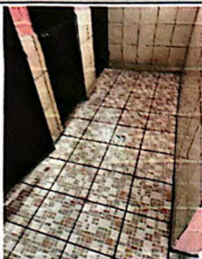
Foto 7: Suministro e instalación de piso antideslizante en baños.
