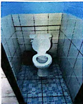
Foto 5: Suministro e instalación de baño + Piso antideslizante.
