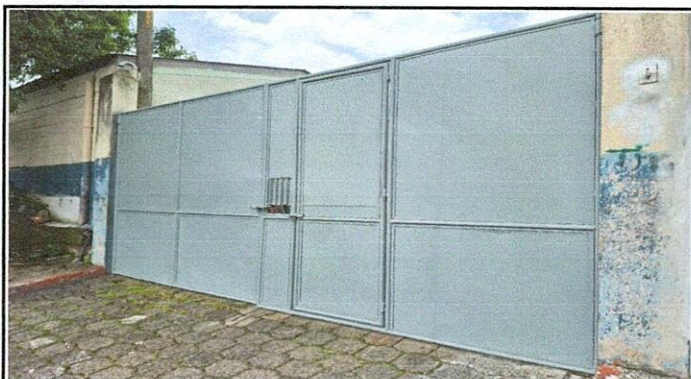
Foto 3: Reparación de columna para portón.
