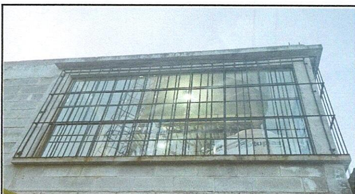
Foto 4: Fabricación e instalación de ventanas
