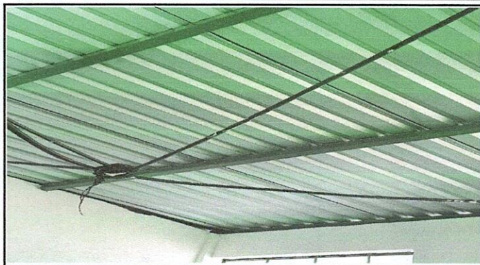
Foto1: Durante techado sanitarios
