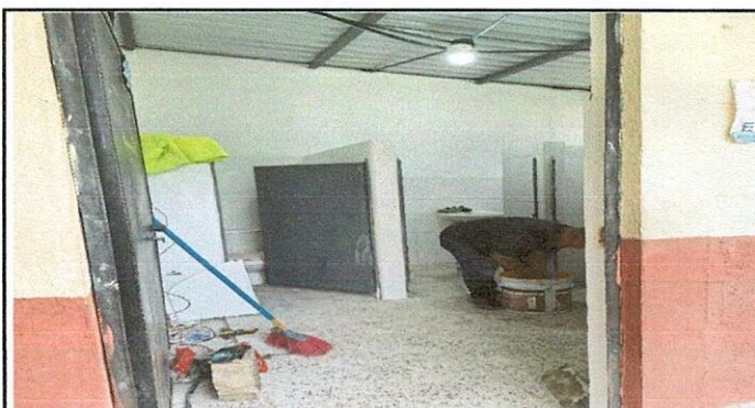
Foto 6: Mantenimiento de puertas en sanitarios
