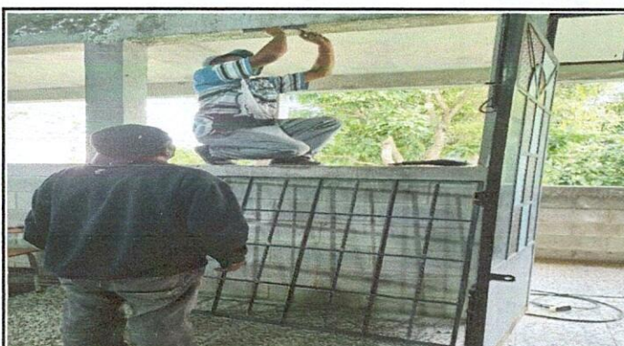
Foto 4: Fabricación e instalación de ventanas.
