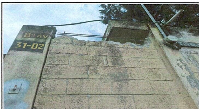
Foto 3: Reparación de columna para portón.
