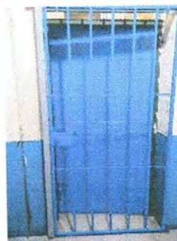
Foto 16: Puerta de entrada de dirección.
