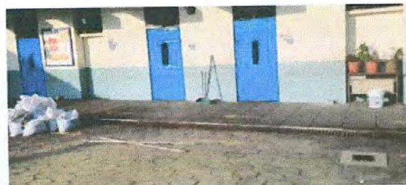
Foto 20: Puertas de aulas.
