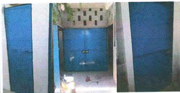
Foto 8: Puertas de baños.
