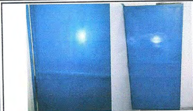
Foto 1: Puertas de baños.
