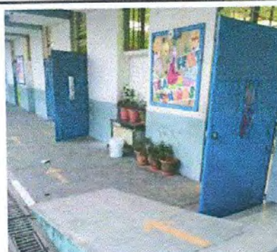
Foto 22: Puertas de aulas.
