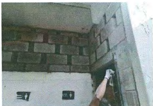
Foto 15: Repello área de baños.
