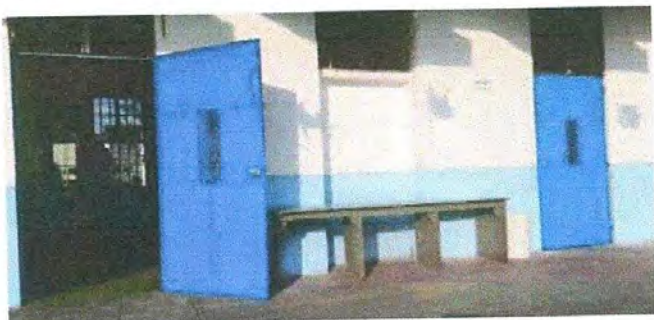
Foto 5: Puertas de aulas, fotografía 1.
