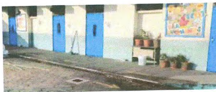
Foto 6: Puertas de aulas, fotografía 2.
