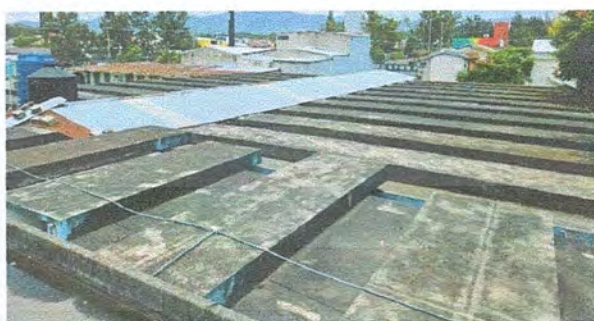
Foto 2: Losas a trabajar
