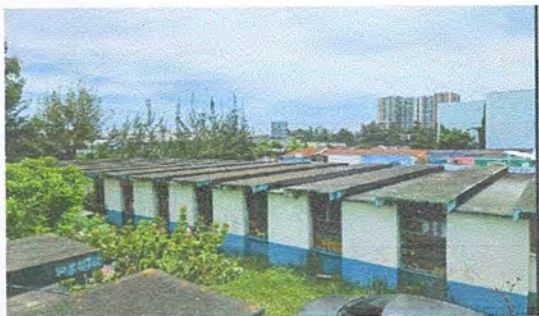
Foto 5: Losas a trabajar
