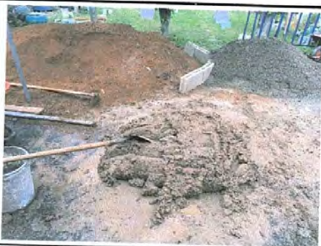
Foto 3: remozamiento pasillo módulo aulas
