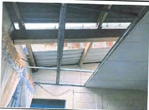
Foto 1: cambio láminas modulo audiovisuales-dirección
