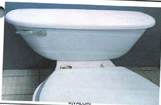
Foto: SANITARIOS DAÑADOS
