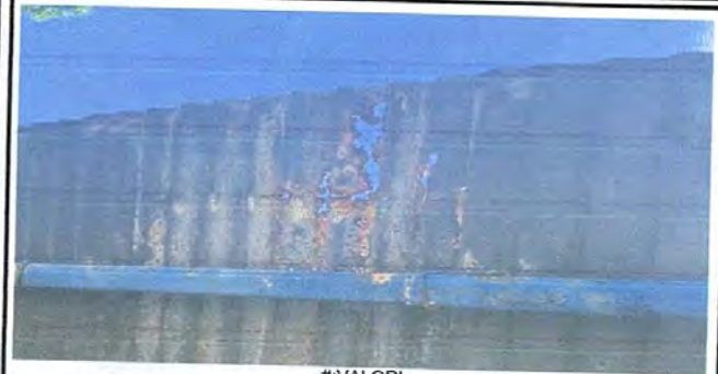
#|VALOR! Foto: LÁMINAS DAÑADAS MÓDULO AUDIOVISUALES-DIRECCIÓN
