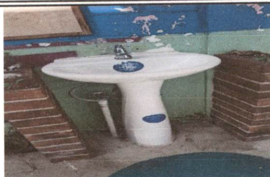
Foto 2: CAMBIO DE LAVAMANOS CON ACCESORIOS
