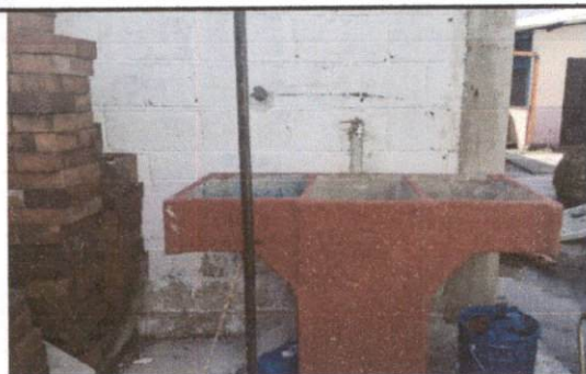
Foto 5: INSTALACIÓN Y MOVIMIENTO DE NUEVA PILA
