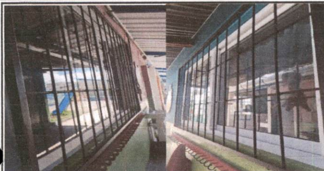
Foto1: REMOZAMIENTO DE BALCONES
