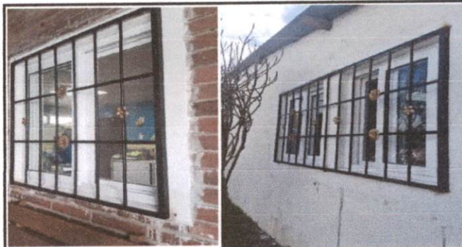
Foto 4: APERTURA DE VENTANAS EN 2 AULAS
