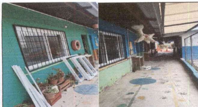
Foto 3: CAMBIO E INSTALACION DE 10 VENTANAS PVC
